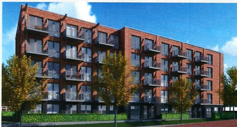
Appartementen aan de Trompweg
