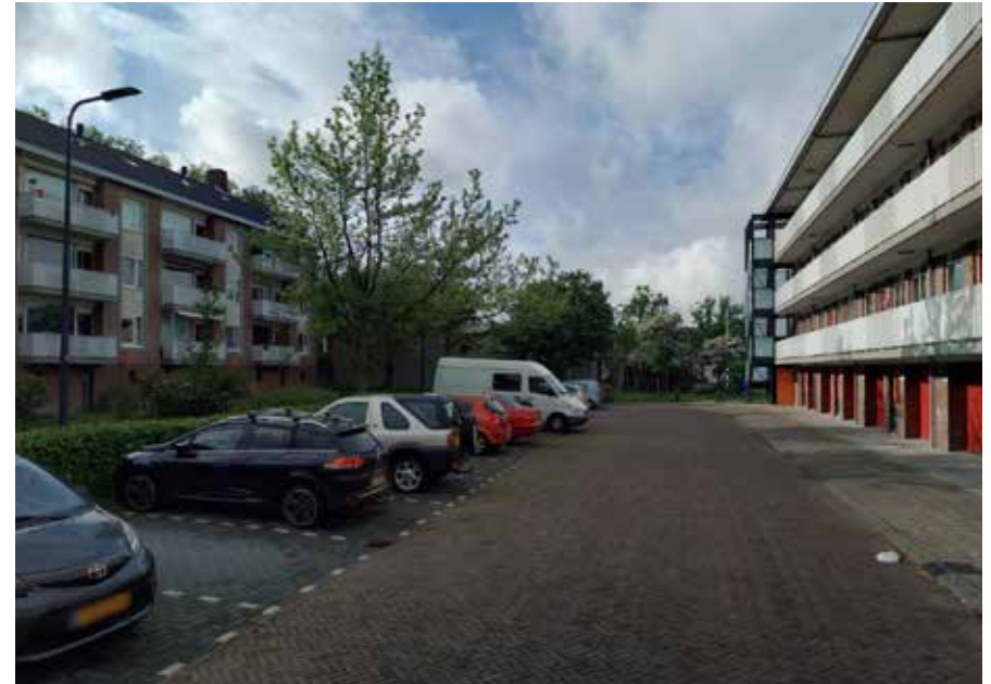
Locatie vanuit het noorden gezien.
