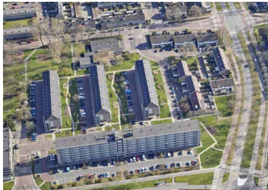
Locatie vanuit het noorden gezien.
