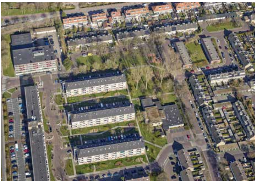
Locatie vanuit het westen gezien.
