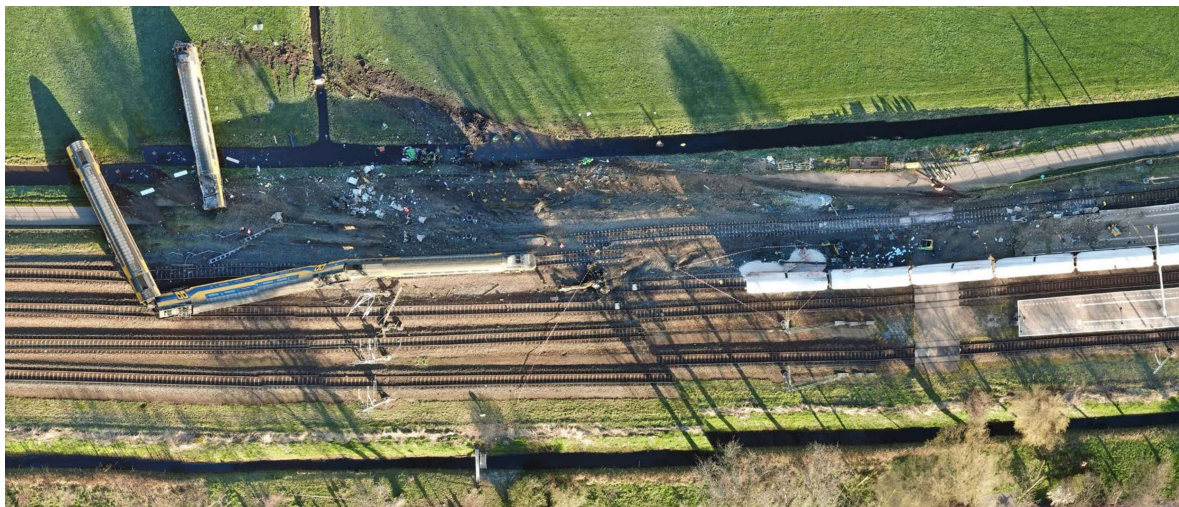
▲ Figuur 20: Drone-beelden van de gevolgen van de aanrijding van de kraan door goederentrein 47612 (rechts, laatste 5 wagens) en vervolgens door reizigerstrein 1409 (links). (bron: politie)
