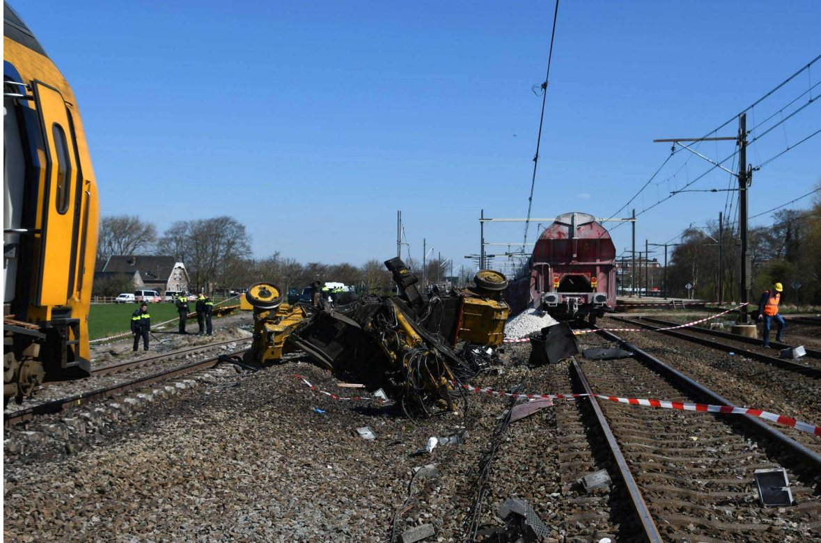
▲ Figuur 48: Restanten van de kraan op lorries, ook is te zien dat de bovenleiding boven sporen 1 en 2 grotendeels weg zijn (foto: politie)
