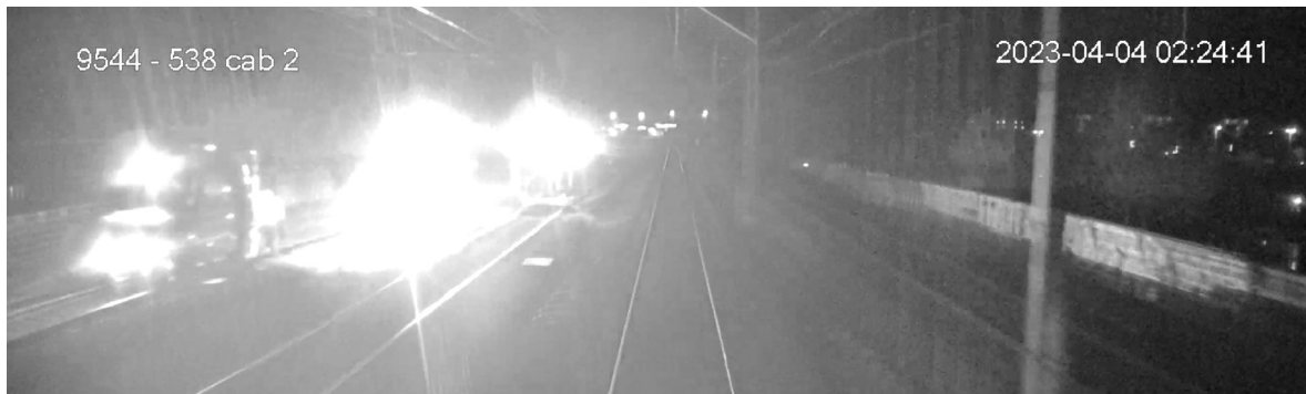
▲ Figuur 15: Fragment van beeld van frontcamera trein 1405, rijdende van Leiden in de richting van Den Haag na passage van de Vinkbrug, de drie fel verlichte plekken (van links naar rechts) zijn de lasbus en de kraan van werklocatie 09 op spoor 4 aan het werk, en in spoor 3 een van de lasbussen van werklocatie 07 (bron: NS).
