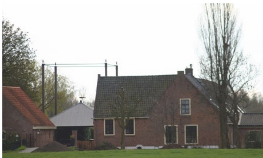
Mariahoeve Rijksmonument Boerderij met drie topgevels en in een steen gemetseld: 1730, zomerkamer 18e eeuw; dwarshuistype, 17e eeuw. Uit de 19e eeuw daterende vrijstaande schuur aan de noordzijde van de boerderij.
