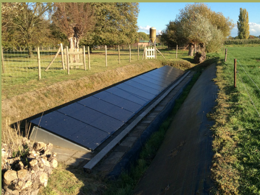
Verdiepte plaatsing om panelen van veraf uit het zicht te houden
