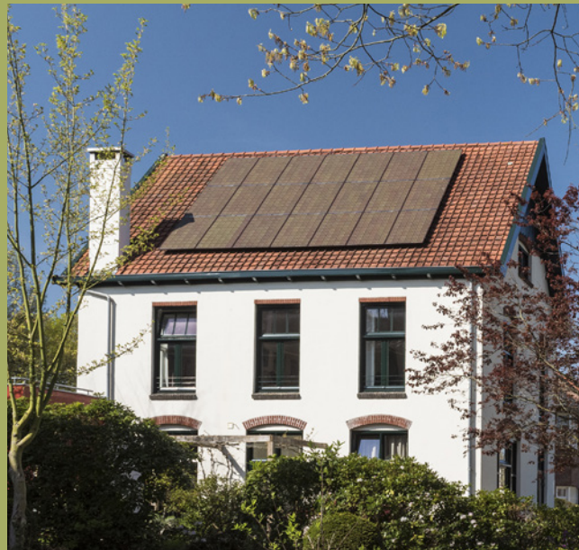
Zonnepanelen met een aangepaste, rode kleur voor zichtlocaties
