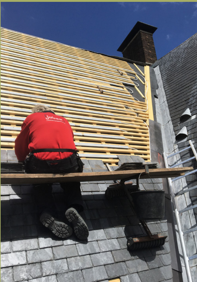
Zonthermisch daksysteem om warmte te winnen voor onder dakpannen en – zoals hier – leien
