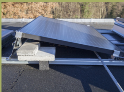
Aangepaste, kleinere hellingshoek om panelen uit het zicht te houden
