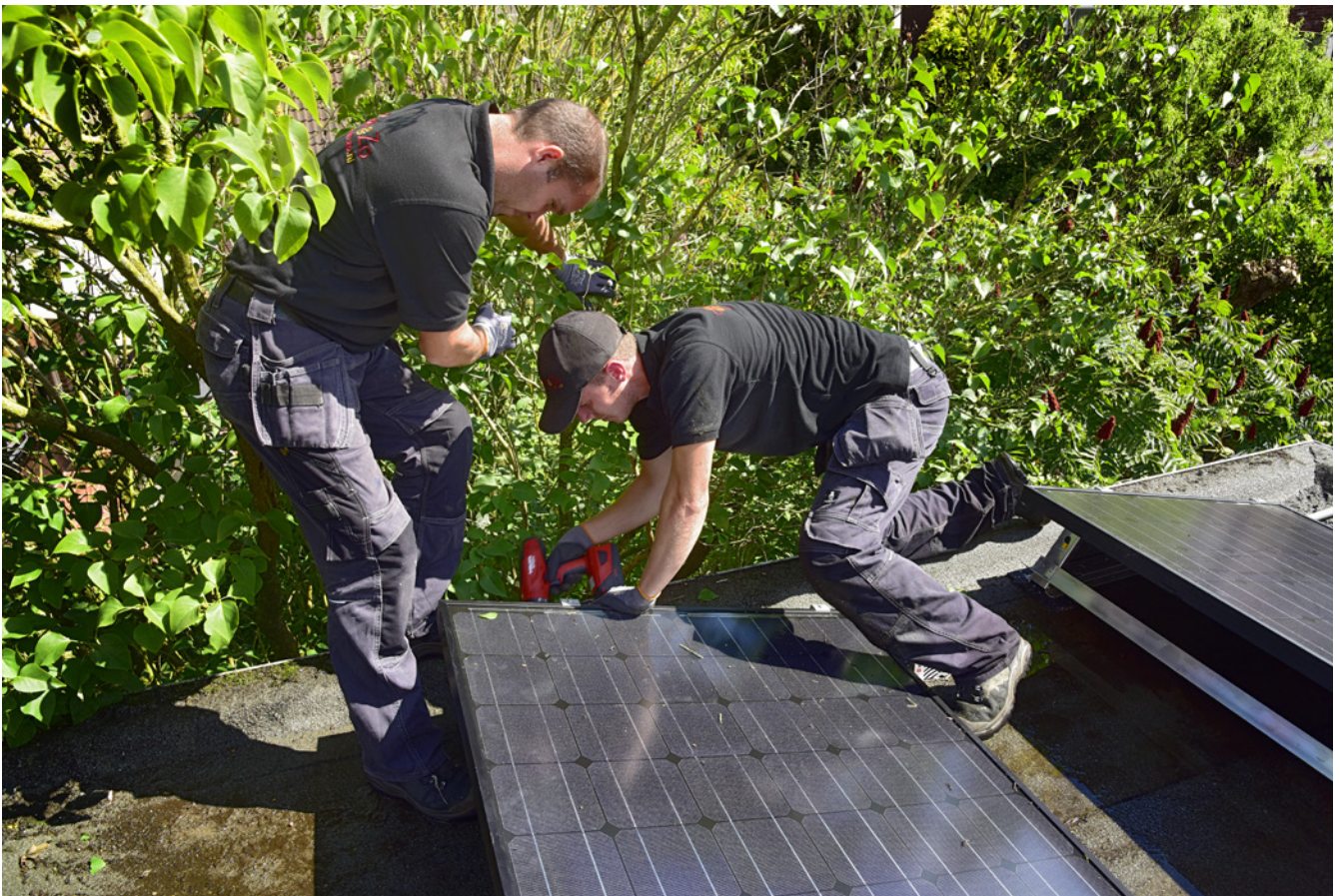
Installateurs aan het werk
