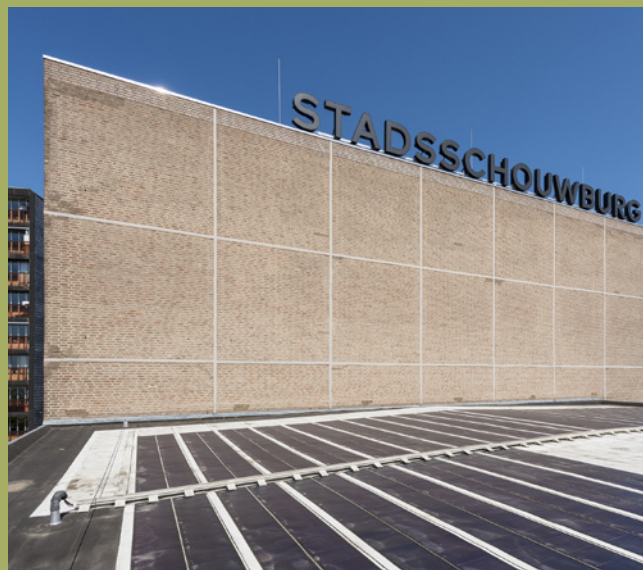
Pv-folie voor stroomopwekking op een plat dak
