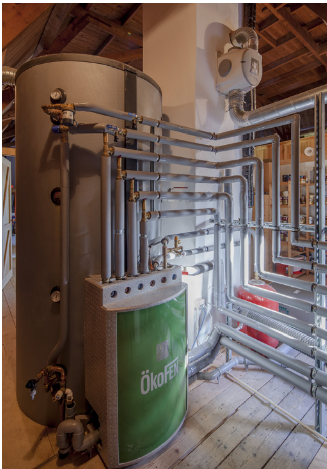
Voorraadvat met warm water – hier extra groot – van een zonnecollectorsysteem op een zolder
