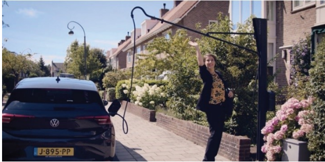
Figuur 2. Kabelgoot, een mat of kabelarm om losliggende kabels te voorkomen op het trottoir
