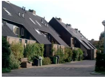
Dakvlak doorgetrokken over voor-aanbouw.
