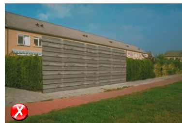
Niet passend door hoogte, materiaal- en kleurgebruik.
