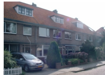
Horizontale geleding door forse overstek en lijst boven de erkers.
