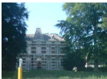
Hoge gevelopeningen afgerond met rolbogen met sluitstenen en verbonden met speklagen.
