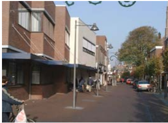
Hoekige gevel met sobere detaillering van de Rabobank.
