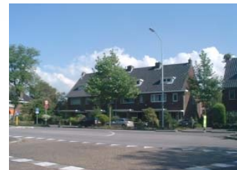
Planmatige woningbouw Krimwijk goede invulling aan het lint.
