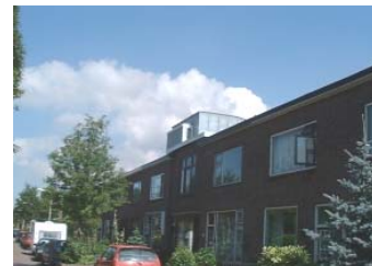
Individuele dakopbouw op geschakelde woningen met platdak.
