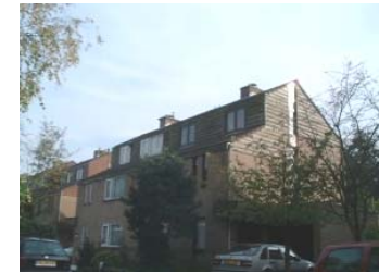
Asymmetrische kap beslagen met houten schroten.
