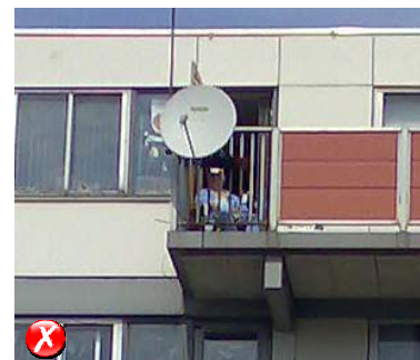
Schotelantenne niet achter balustrade geplaatst.
