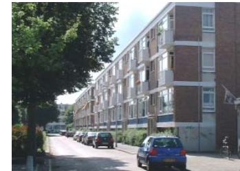
Portiekflats met horizontale gevelge- leding centraal in de wijk.
