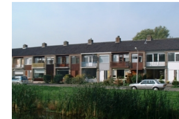
Gevarieerd kleur- en materiaalgebruik.
