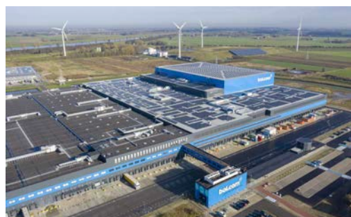
Zonnedak met 13.000 zonnepanelen en de nabijgelegen windmolens (foto: Bouwbedrijf v.d. Ven)
