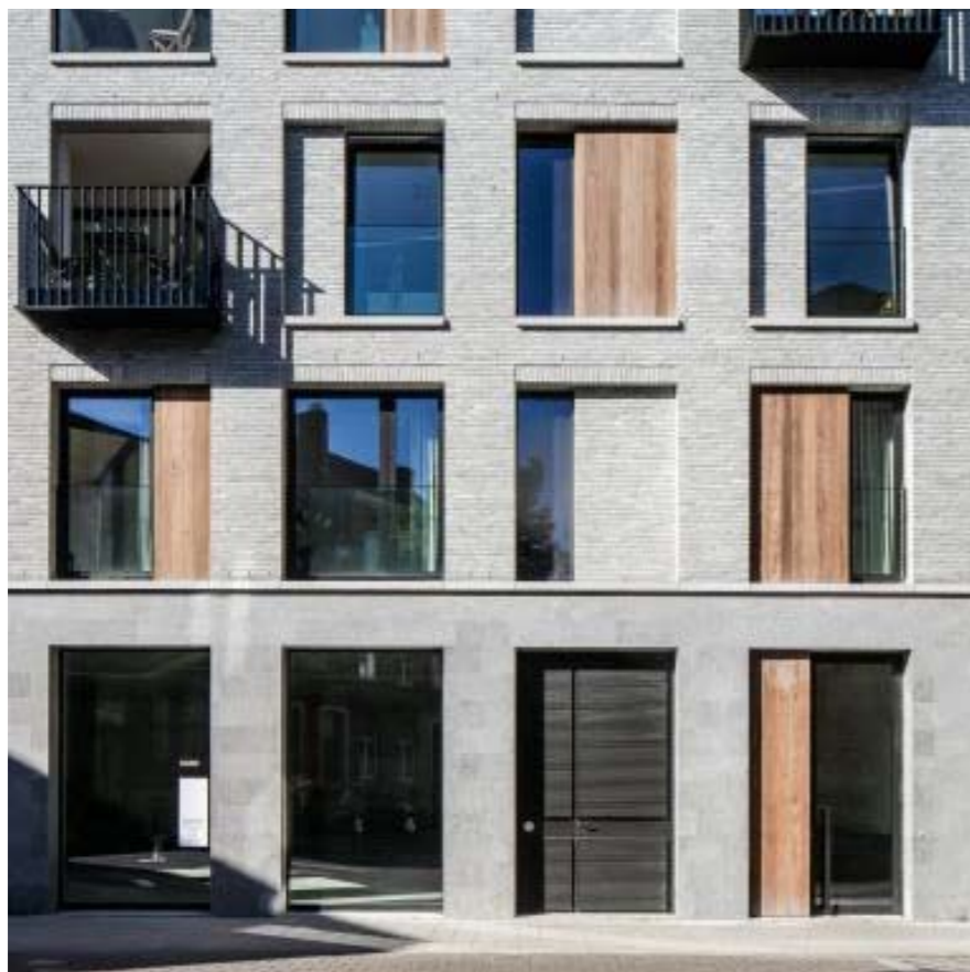
sobere gevel met plint
