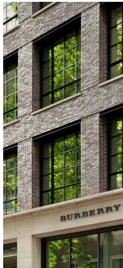
verbijzondering in het metselwerk
