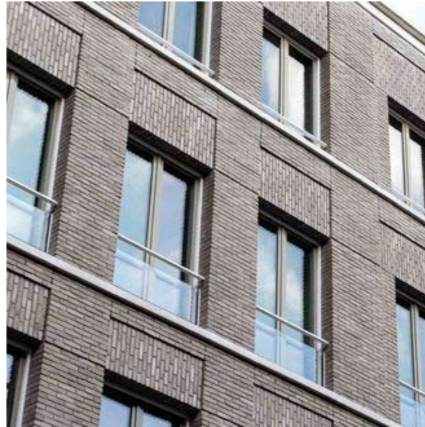
verbijzondering in het metselwerk
