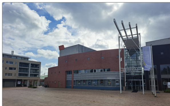
Aanbieden gezamenlijke centropakketten
