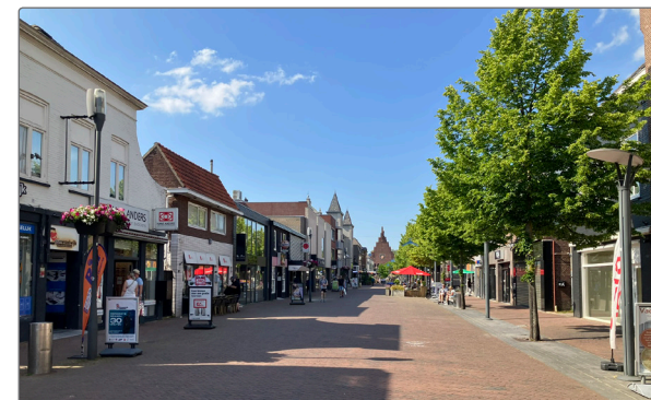
'Ademruimte' in de Stationsstraat
