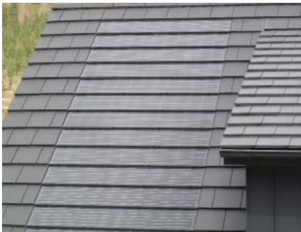
Dak met geïntegreerde pv-panelen
