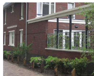
Bebouwde erfgrans thv doorsteek
