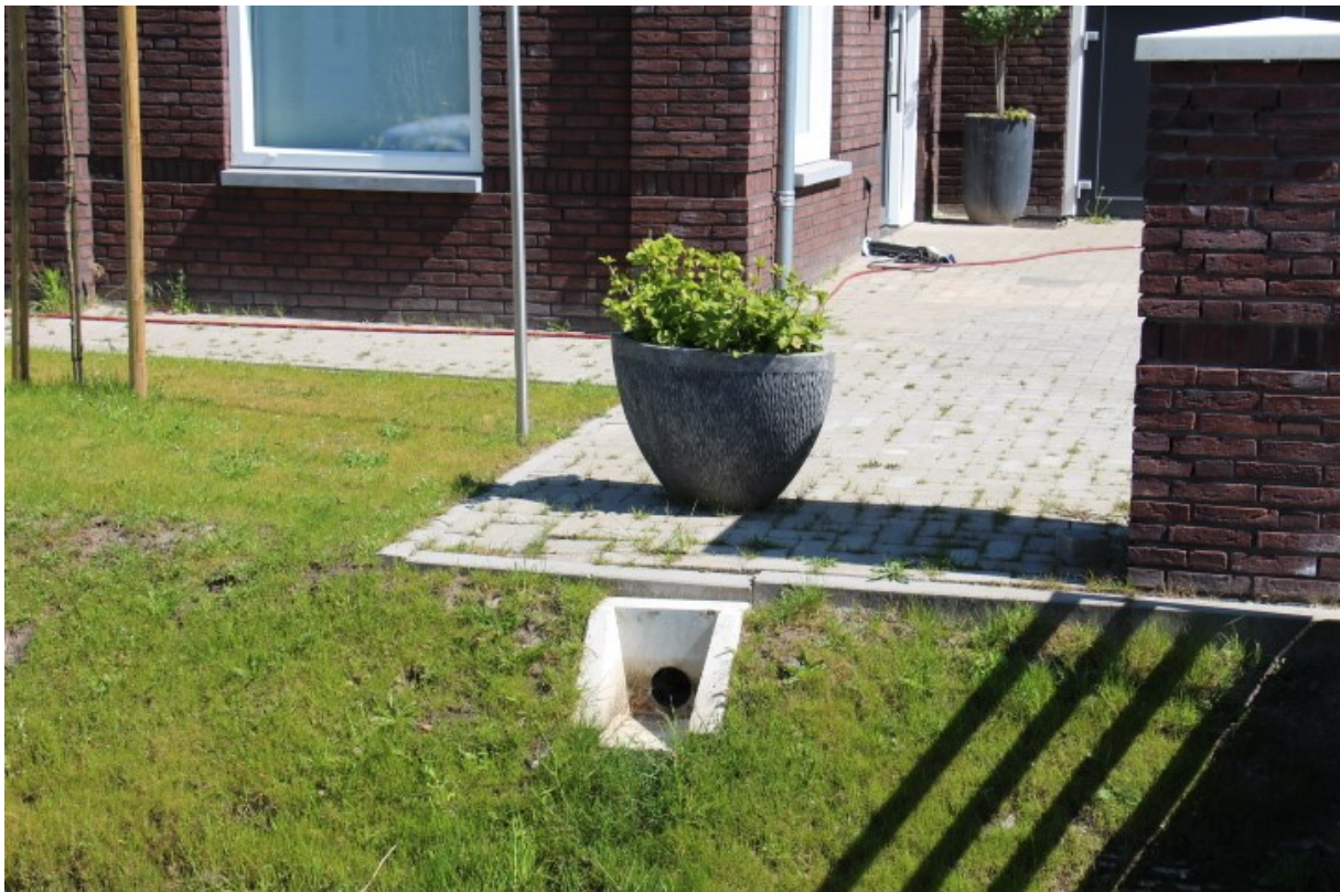
Regenwater afgekoppeld naar groen en oppervlaktewater
