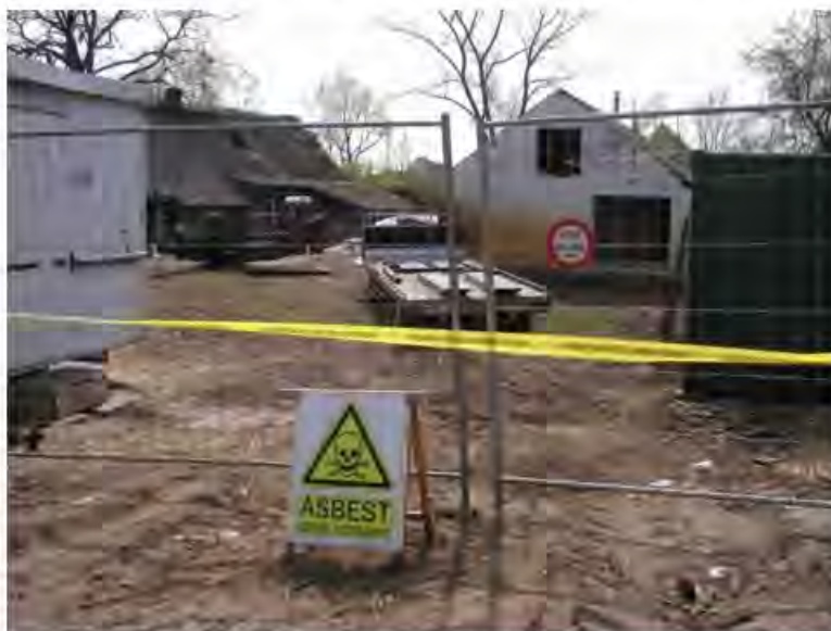
Figuur 17: Afscherming van een asbestverdachte locatie
