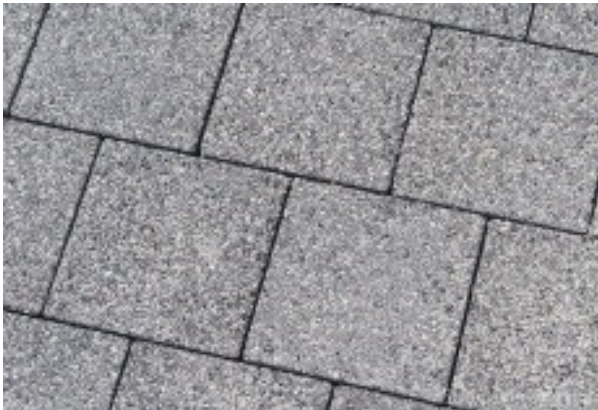
Voorbeeld dubbelbetonstraatstenen 200 x 200 x 80mm
