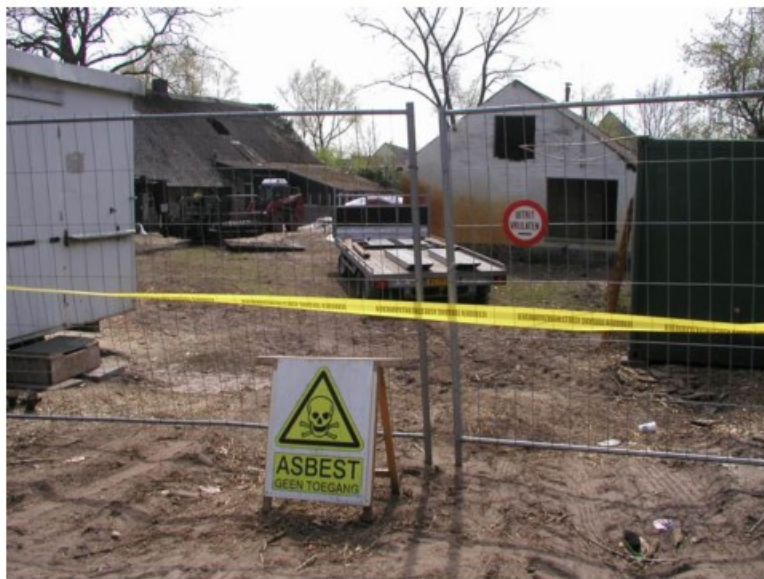
Figuur 17: Afscherming van een asbestverdachte locatie
