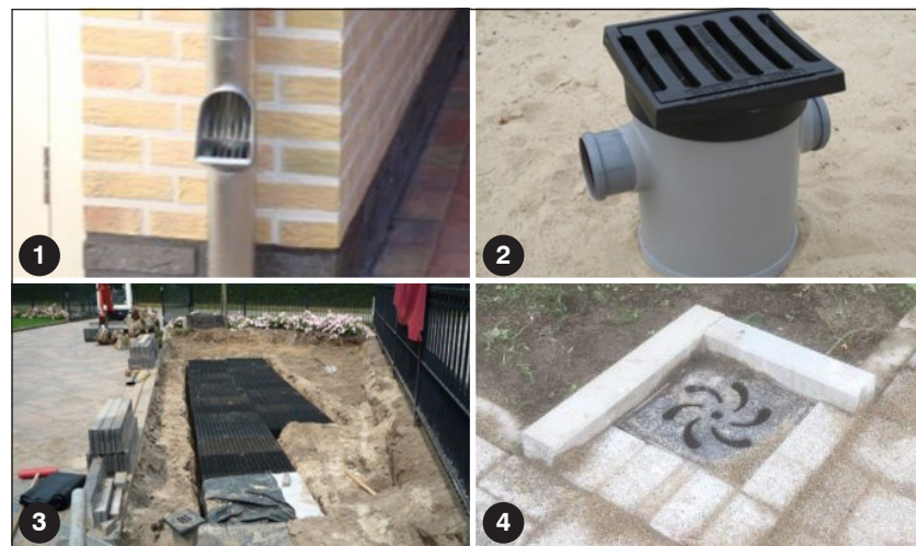
(1) bladafscheider (2) zandvangput (3) infiltratiekragen (4) overstortput
