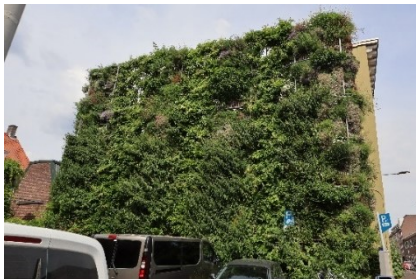
Groene gevel- hangende tuin
