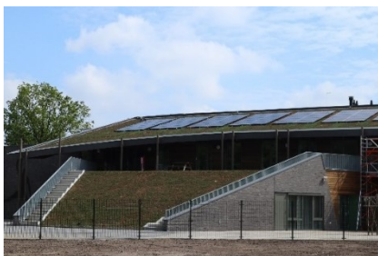
Groen dak- dunne substraat laag
