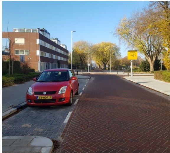
Plaatje parkeerplaatsen met betonstraatstenen zwart.
