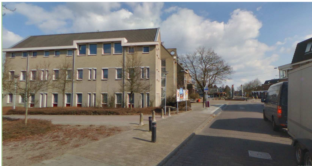
Aan de Raadhuisstraat ter hoogte van nummer 64.
