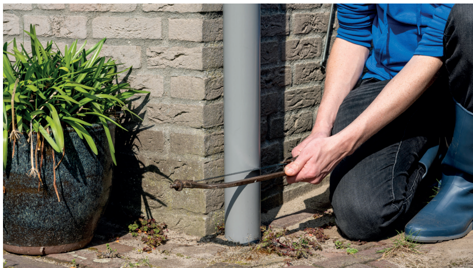
Vorbereidingen voor het plaatsen van een regenton.
