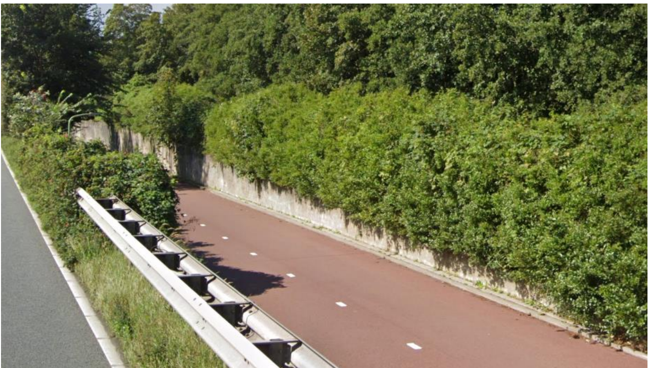
Figuur 23: Noordelijke entree van de onderdoorgang ter hoogte van het Louwman museum (bron: Google Streetview)
