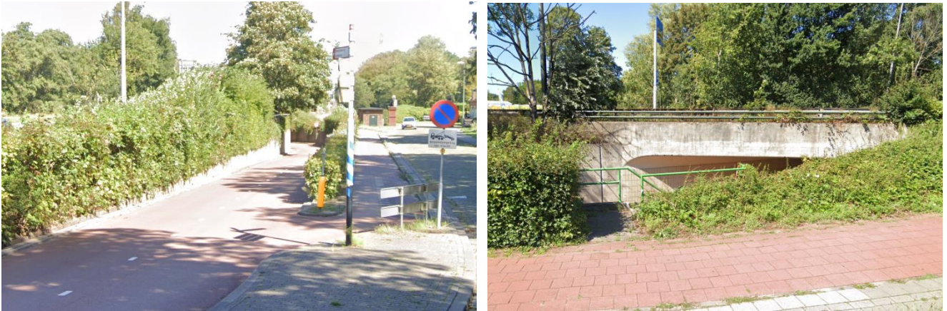
Figuur 22: Zuidelijke entree voor fietsers (links) en voetgangers (rechts) van de onderdoorgang ter hoogte van het Louwman museum (bron: Google Streetview)
