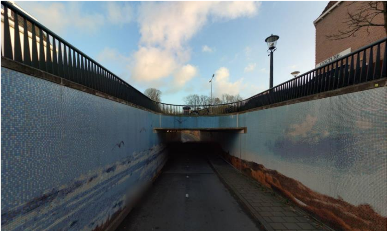
Figuur 16: Noordelijke entree onderdoorgang Wasseenaar ter hoogte van het kruispunt N44/N448 (Lange Kerkdam/Papeweg) (bron: Cyclomedia StreetSmart)
