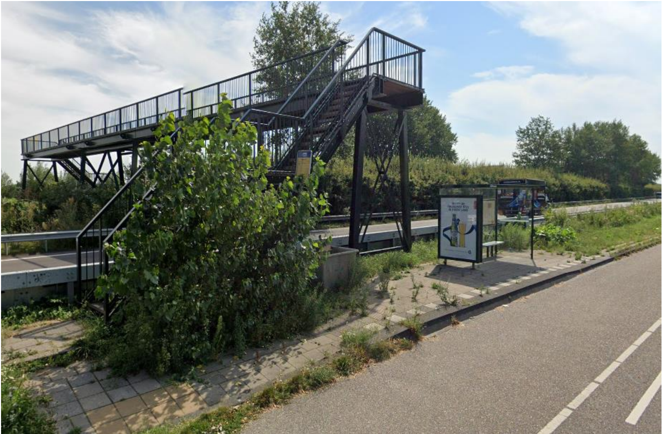
Figuur 15: Noordelijke opgang voetgangersbrug over de N44 ter hoogte van Maaldrift (bron: Google Streetview)
