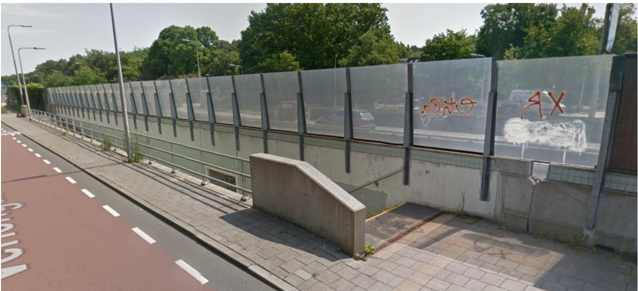
Figuur 21: Zuidelijke entree onderdoorgang N44 ter hoogte van Kerkehout (bron: Google Streetview)
