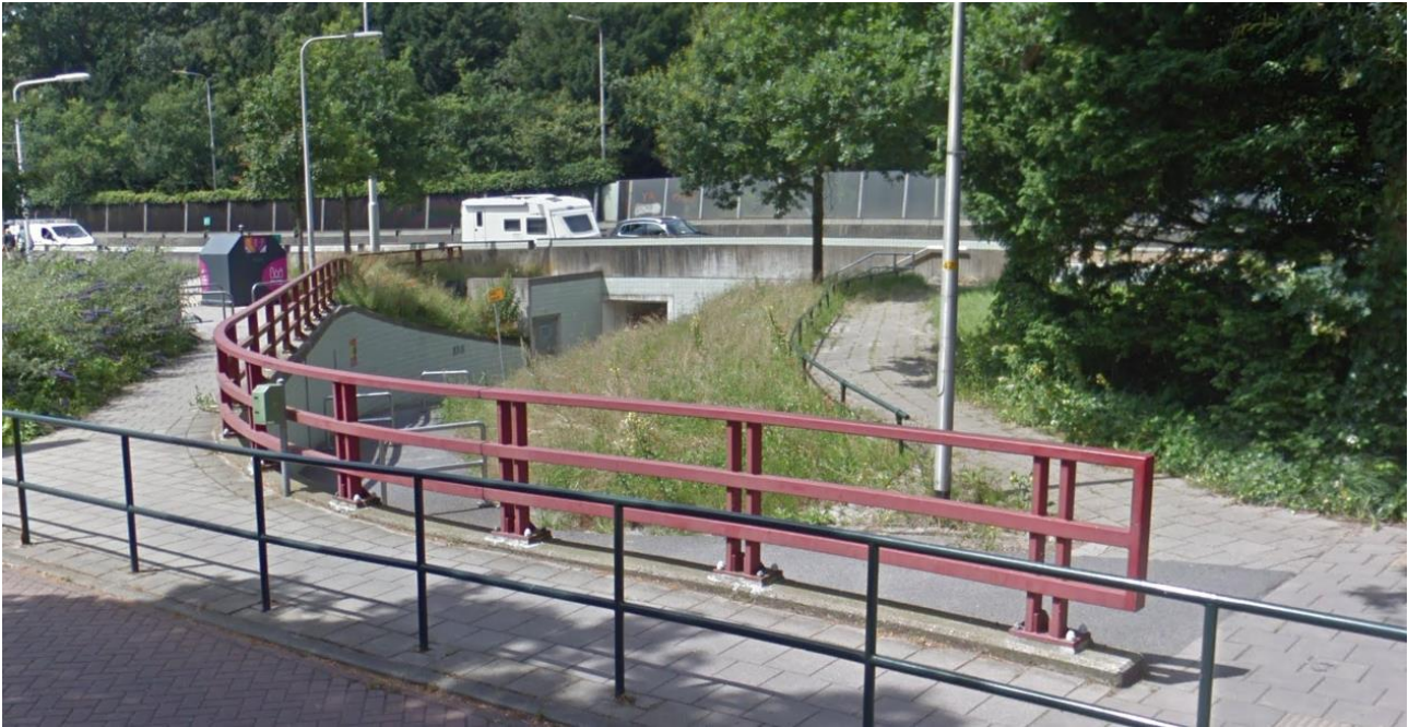
Figuur 20: Zuidelijke entree onderdoorgang N44 ter hoogte van Kerkehout (bron: Google Streetview)
