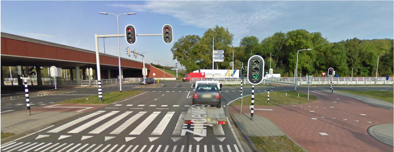
Figuur 75: Kruispunt Zijdeweg/N44. Het fietspad dat hier rechts van de Zijdeweg ligt en de N44 kruist is onderdeel van het fietsrouten netwerk. In de regionale variant bevat dit kruispunt twee opstelstroken voor rechtsafslaand verkeer
