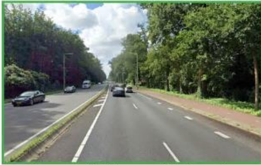
Landgoed - Vrijliggend fietspad
