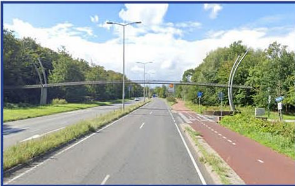
Stad - Vrijliggend fietspad
