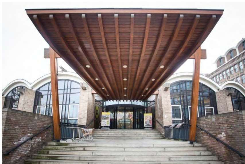
Indrukwekkende trap en luifel uit de bouwtijd.
