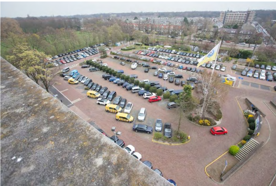
Zicht op een deel van het parkeerterrein, het deel vóór de rotonde, is nog goeddeels oorspronkelijk in opzet en bestrating. Parkeervakken waar de wegenwachtauto's staan, zijn van latere datum, evenals de vakken met laadpalen pal aan de voorgevel van het kantoorgebouw.
