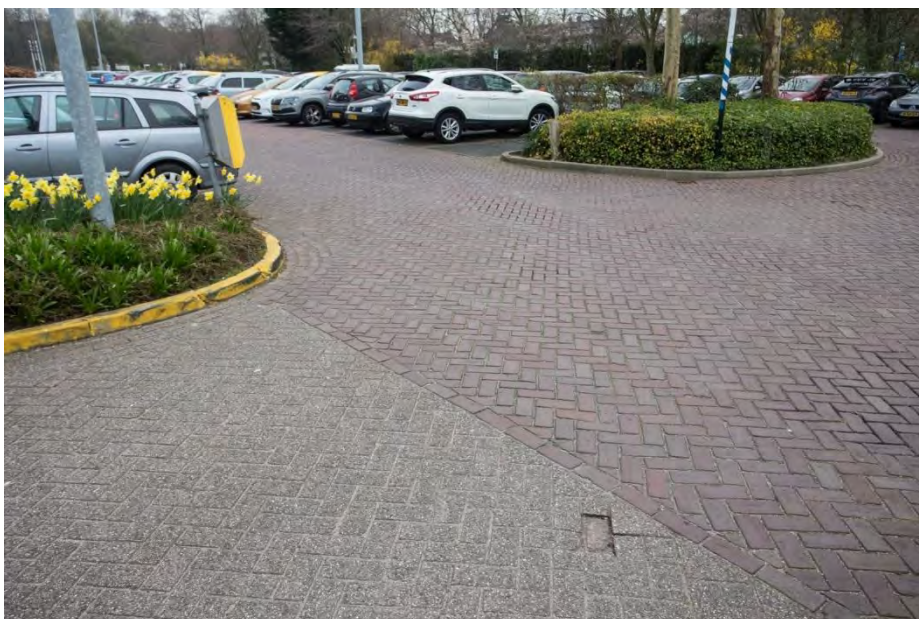
De meest recente uitbreiding in betonklinkers, aansluitend op de lus (aangepaste bestrating ter plaatse) van de uitbreiding uit omstreeks 1973.
