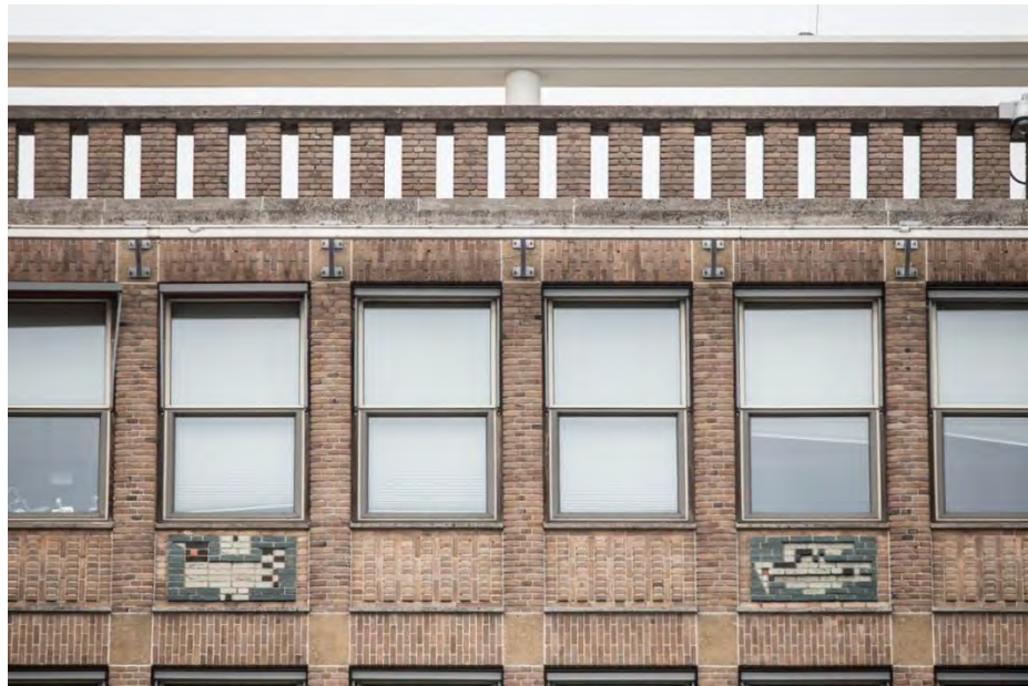
Het metselwerk van de muurdammen is vanaf de steiger gemetseld, al het overige werk is geprefabriceerd en betreft beklede elementen van beton.
