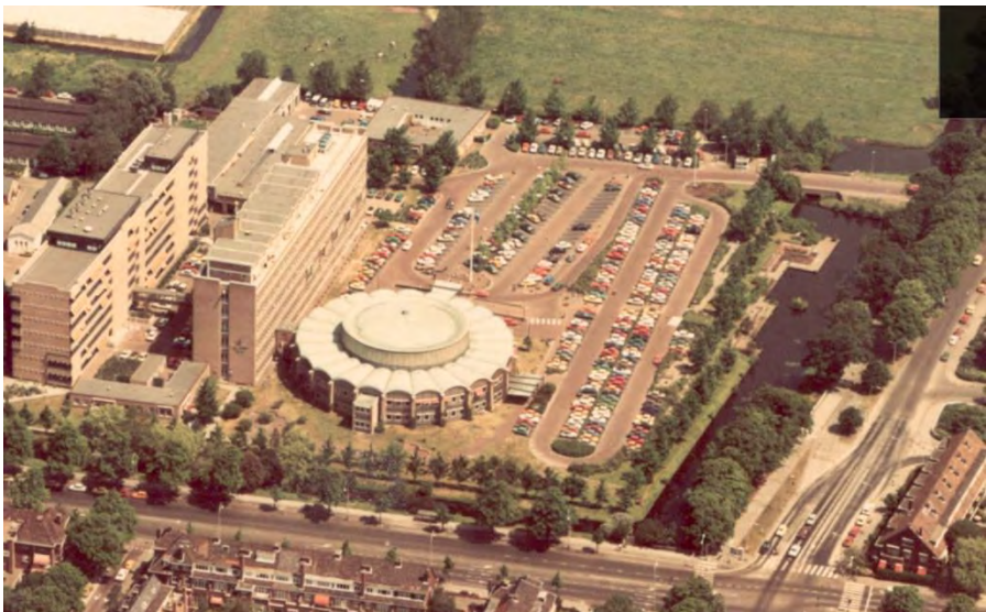
Luchtopname uit 1976 toont langs de Wassenaarseweg de versmalde vijver, de begin jaren zeventig aangelegde waterkant en de forse uitbreiding van de parkeerplaats daarlangs. Aan de Van Alkemadelaan is de oorspronkelijke tuinaanleg uit de jaren zestig nog intact. De zonnewijzer is op de foto op een gazon te zien (zonder huidig grindbed).
