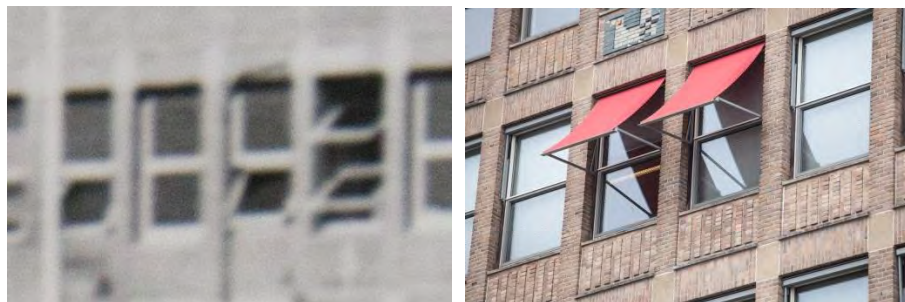
Vensters uit de bouwtijd links op een foto uit de jaren zestig, rechts de huidige vensters en toegevoegde buitenzonwering. De vensters uit de bouwtijd werden geleverd door de firma Radefa uit Apeldoorn (faillissement in de jaren tachtig).
