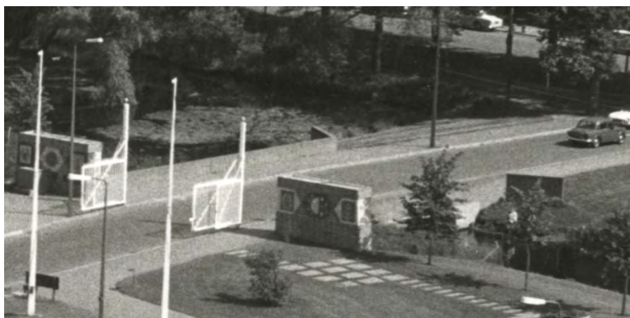
Detail van een opname in de jaren zestig (vanaf het kantoorgebouw) met het huidige straatprofiel. Let ook op de hekken die vrij staan van de gemetselde pylonen én op de vlaggenmasten (die thans niet meer bestaan).
