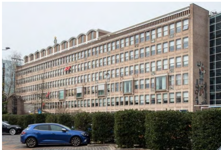
De voorgevel van het pand in huidige toestand. Vernieuwing van de vensters met behoud van oorspronkelijke vensterindeling is de voornaamste aanpassing. De rail voor de glazenwasser dateert ook niet uit de bouwtijd.
