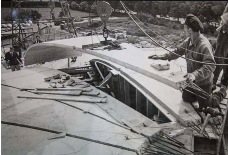
Bekende foto van de laatste plaatsing van de koepелеlementen.
