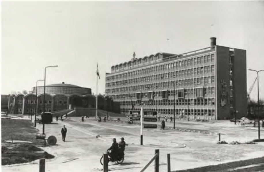
Parkeerterrein in aanleg. Vlaggenmast zonder fietsenluifel en de lantaarnpalen van de firma Bronswerk al opgericht. Prominent bij inrijden een grote wegwijzer van de ANWB.
