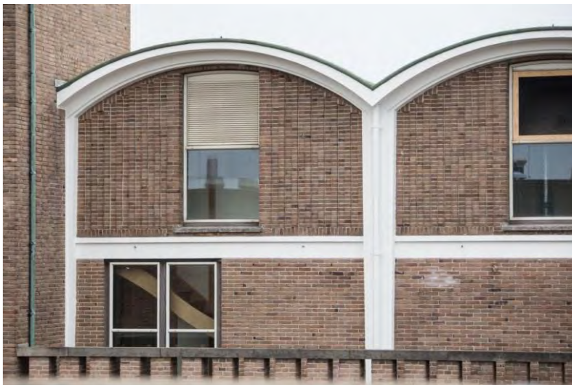
Deel van de gevels van de kantine, met siermetselwerk aansluitend op de schaaldaken.
