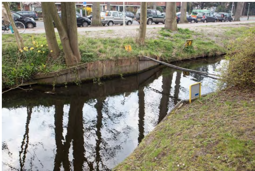
De bruggenhoofden herinneren nog aan een bruggetje dat hier ten tijde van de aanleg van de Van Alkemadelaan zou zijn gemaakt.
