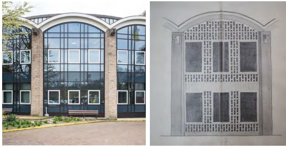
De huidige puien in de gevels van de rotonde, rechts een vroeg (niet uitgevoerd) ontwerp.
