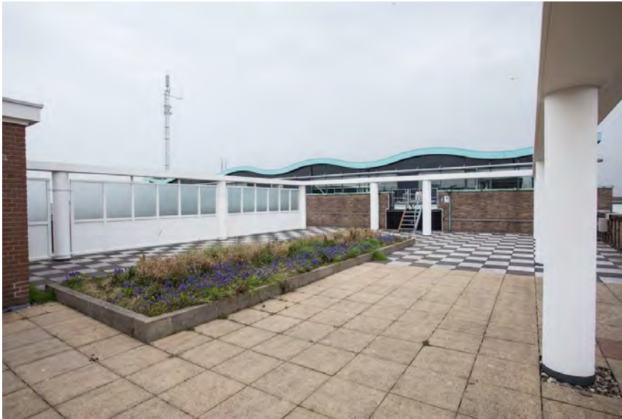
Pergola op het dak, met in de achtergrond het golfdak van één van de jongere kantoorgebouwen.
