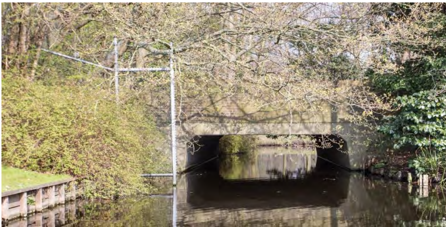
De brug gezien vanuit het tuin/parkgedeelte van het ANWB-terrein. In de jaren zestig zou de fotograaf deze opname alleen vanaf het water kunnen maken.
