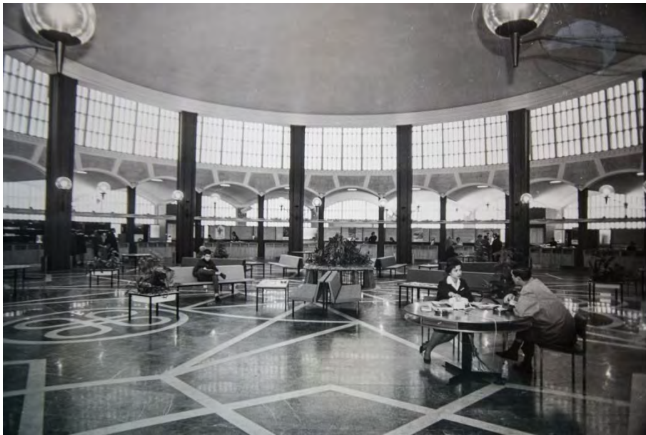
Opname kort na de voltooiing van het werk, met goed zicht op de kolomconstructie, de ringbalk, de koepel en in de achtergrond de schaaldaken van de zijbeuk.
