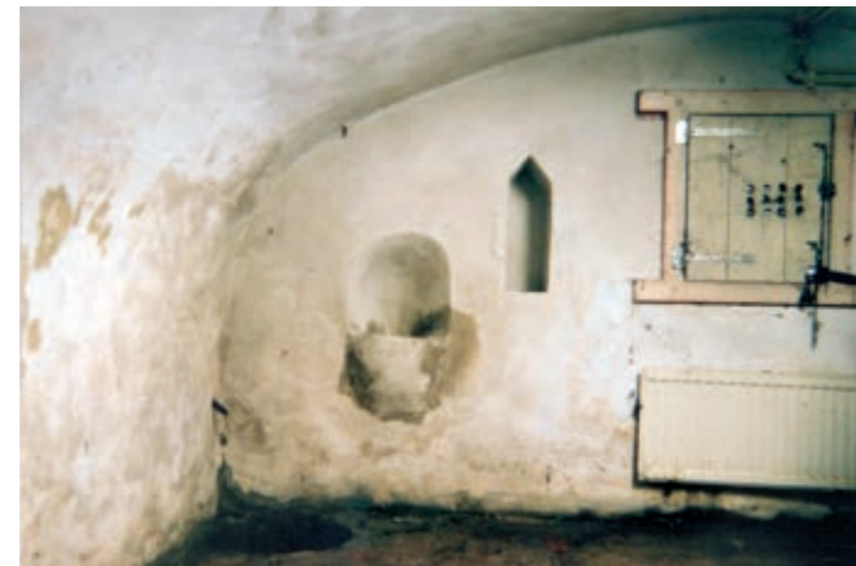
Kelder van boerderij Huis ter Weer, Deijlerweg 153. Foto 2006.
