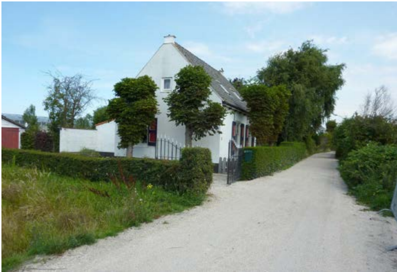
Hoge Klei met hagen aan weerszijden van de onverharde weg. Foto 2010.
