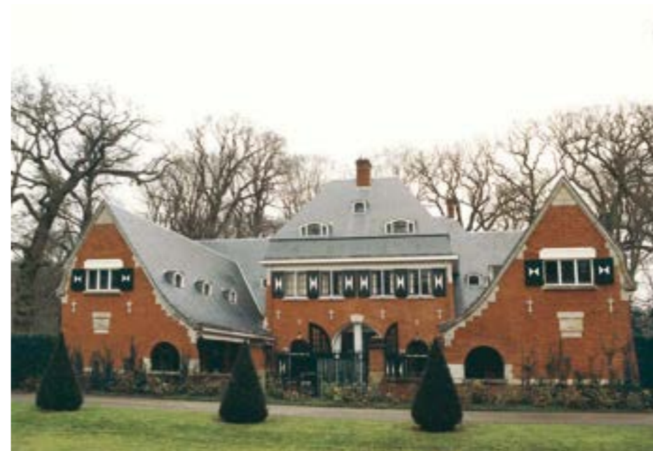
Koetshuis annex chauffeurswoning en garage van Frisiastate uit 1910. Foto 2003.
