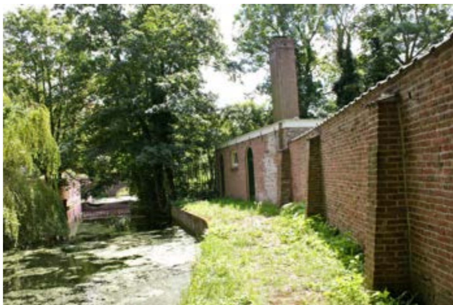
Ketelhuis en muur van moestuin villa Ruys. Foto Mariëtte van Lit.
