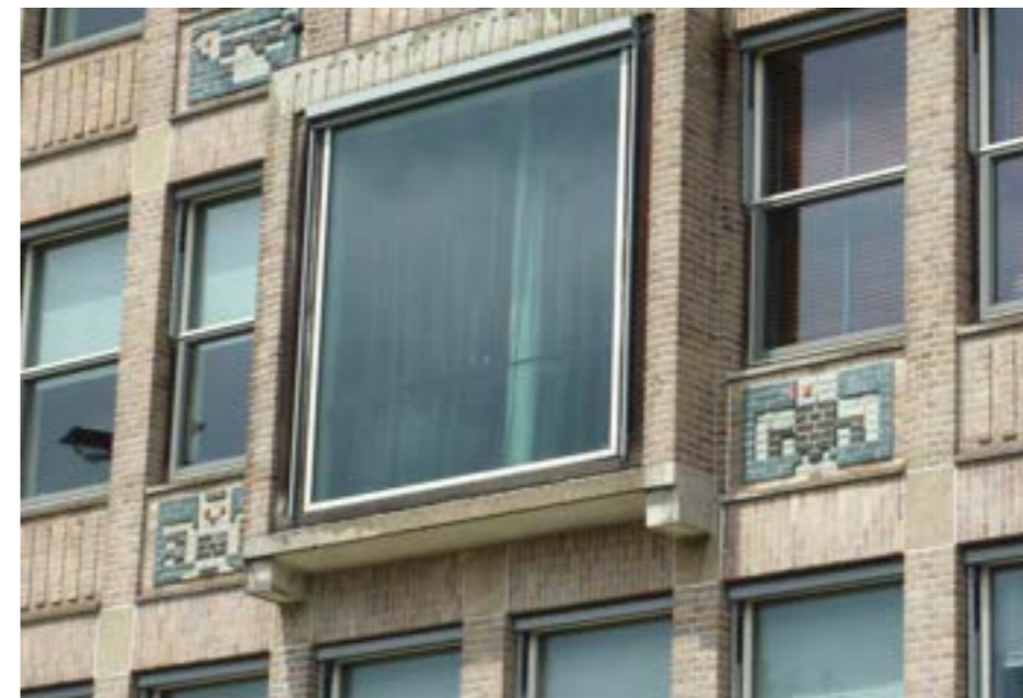
Detail van de gevel van het ANWB-kantoor.
