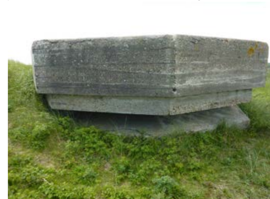
Bunkerelement D 19 van de Vleermuisbunker. Foto 2013.
