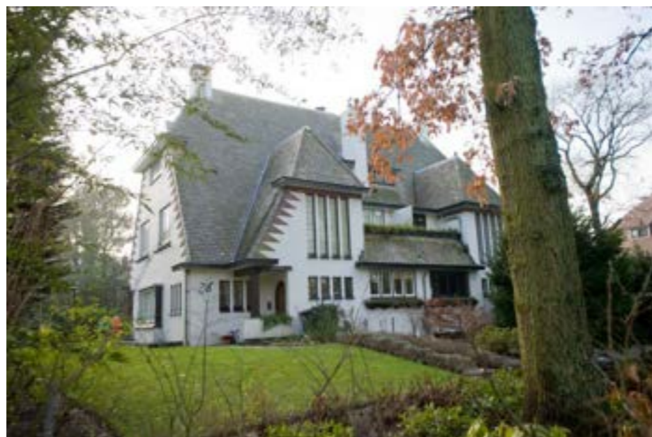
Teylingerhorstlaan 19-21, een dubbel woonhuis met drive-in garages uit 1932 van architect P.J. Houbolt. Foto 2008.
