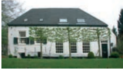
Boerderij De Driespong, Van der Oudemolenlaan 13. Foto 2006.
