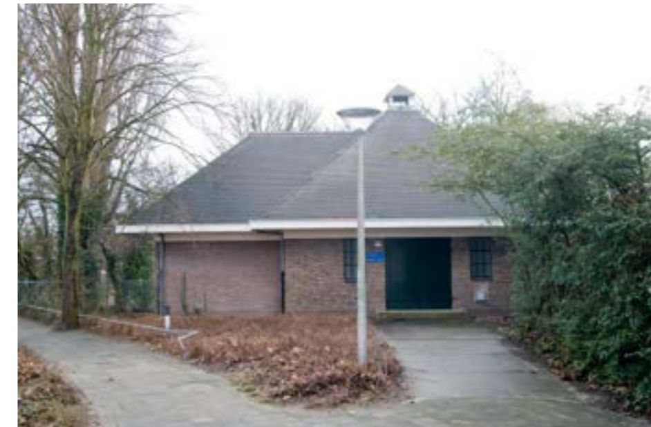
Afvalwatertransportgemaal op Van Zuylen van Nijveltstraat 83. Foto 2012.
