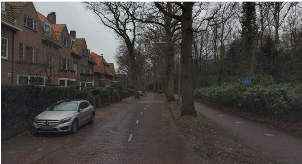
Figuur 3: Huidige wegbeeld met middenstreep en incidentele verkeersdrempel. De ruimte voor de voetganger wordt hier ook gebruikt om te parkeren (Foto Cyclomedia).
