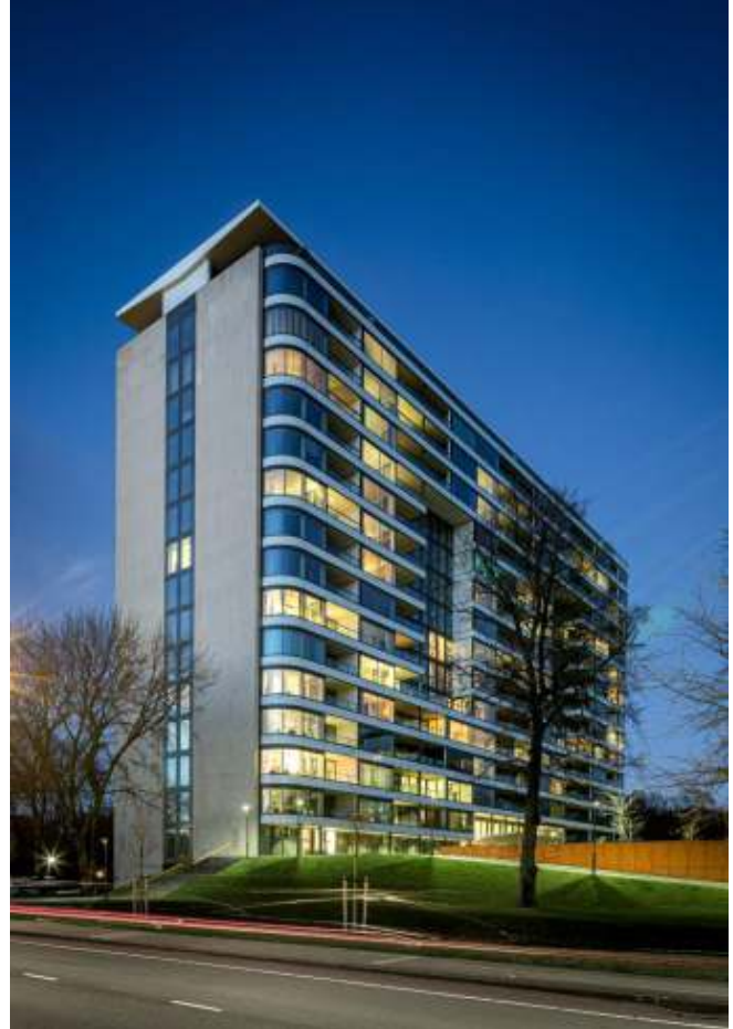
Haagse hoogbouw: transformatie Shell gebouw
