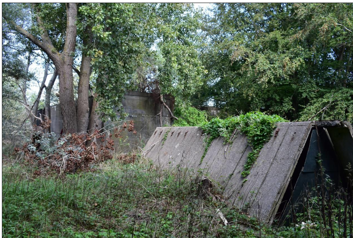
Schuilloopgraaf bij de telefoonbunker.
