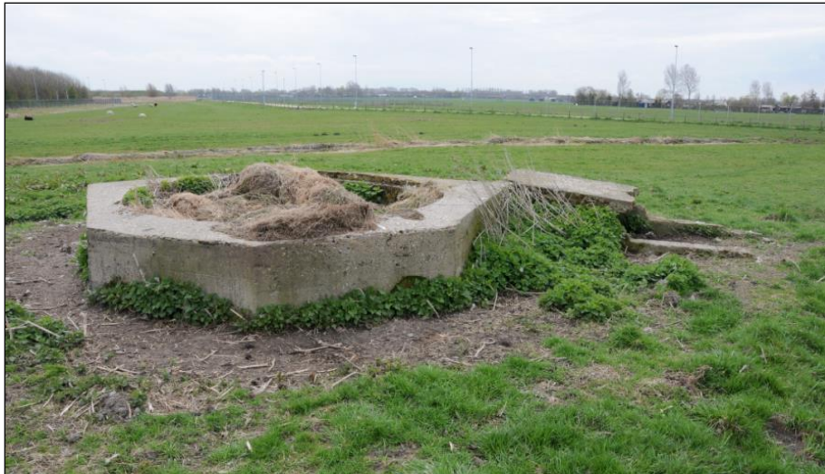
Fundering van de geschutskoepel bij de tankgracht. 56
