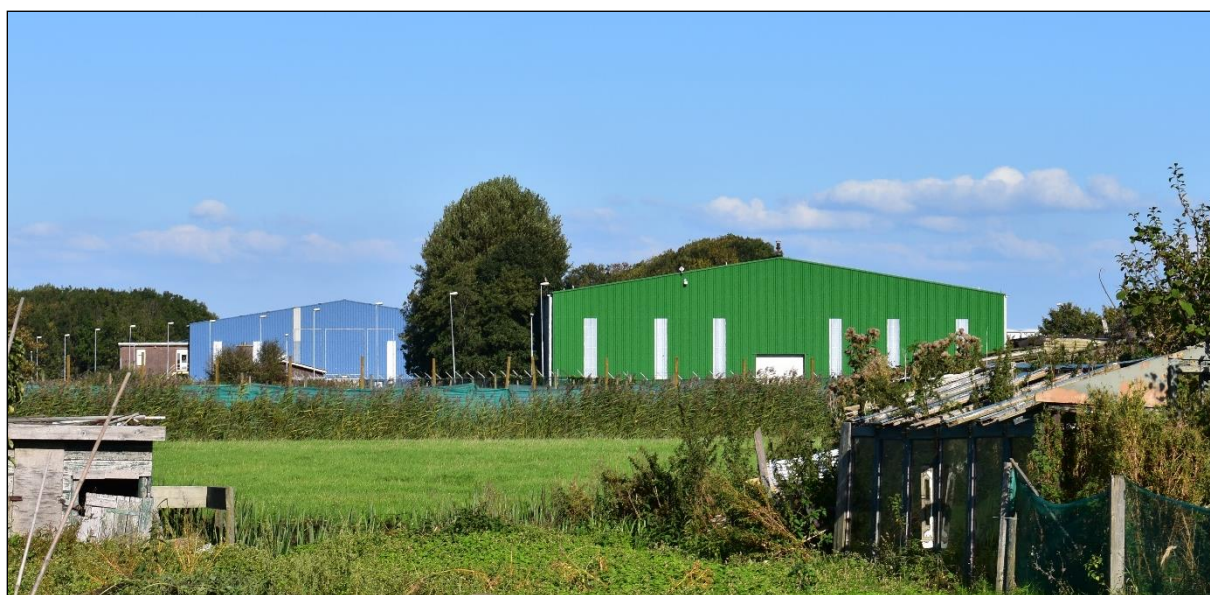
Hangars 1 (groen) en 2 (blauw) uit 1947, achtergevels.
