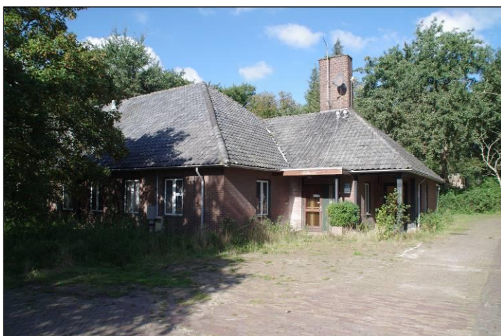
Ingang ontspanningsgebouw nr. 870.
