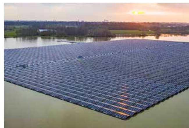
Figuur 20: Drijvende zonnepanelen
