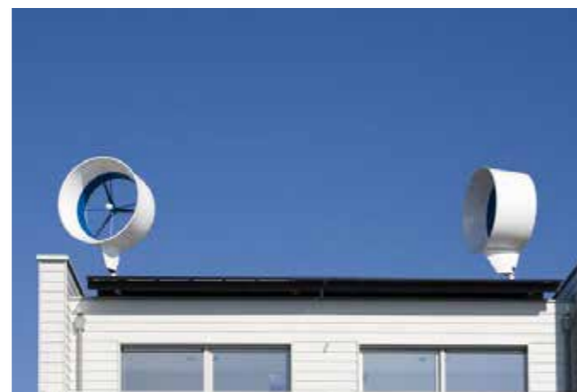
Figuur 21: Windturbines op daken
