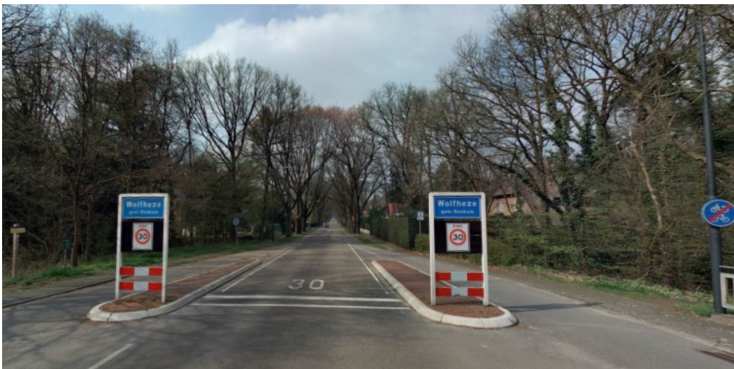
Figuur 14: Voorbeeld poortconstructie (Wolfhezerweg, Wolfheze).
