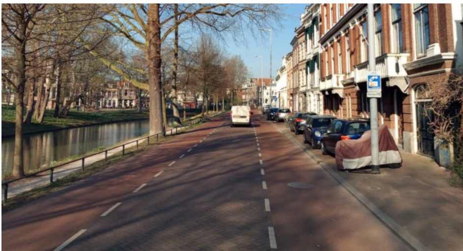
Figuur 16: Voorbeeld inrichting wegvak met fietsstroken in asfalt en rijbaan in klinkers (Wittevrouwensingel, Utrecht).
