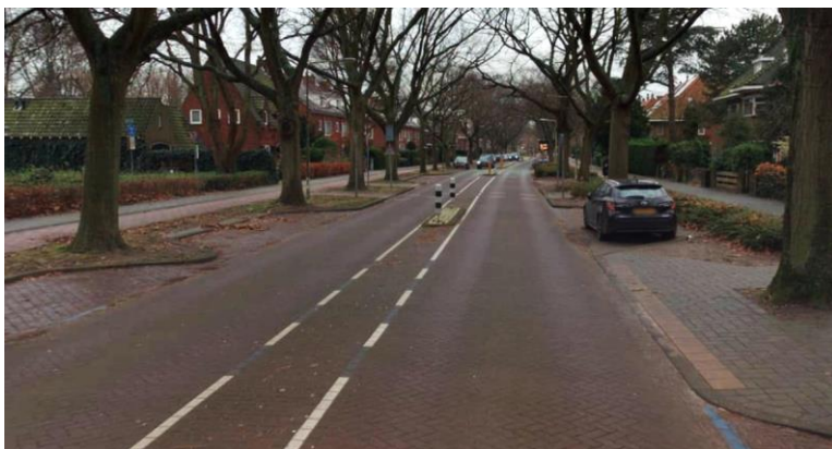
Figuur 3.4: Stille elementenverharding op de Storm van 's Gravesandeweg
