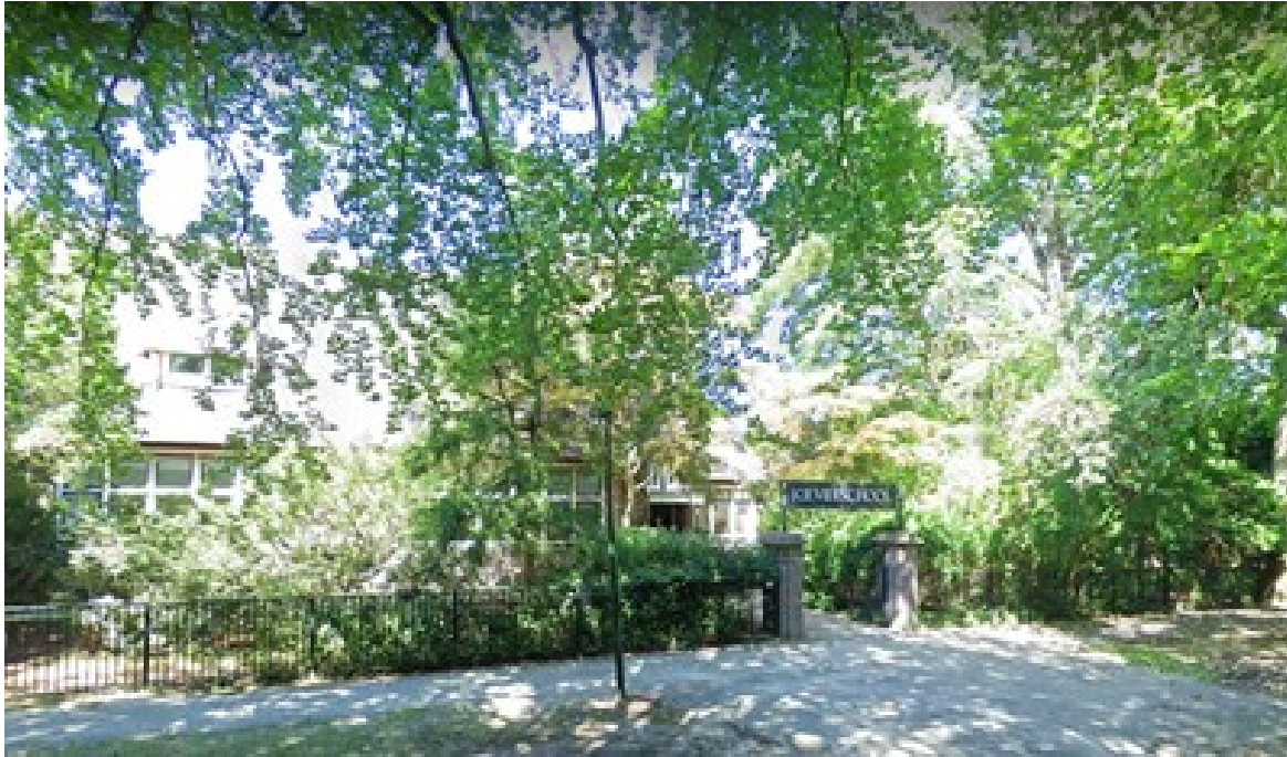
Afbeelding project Kieviet school renovatie/nieuwbouw
