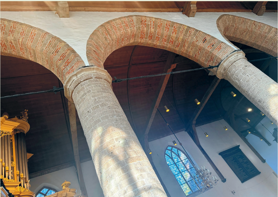
Doorkijk door de bogen naar de tongewelven van de Dorpskerk. Boven de tongewelven wordt een isolatiedeken van pure schapenwol aangebracht
