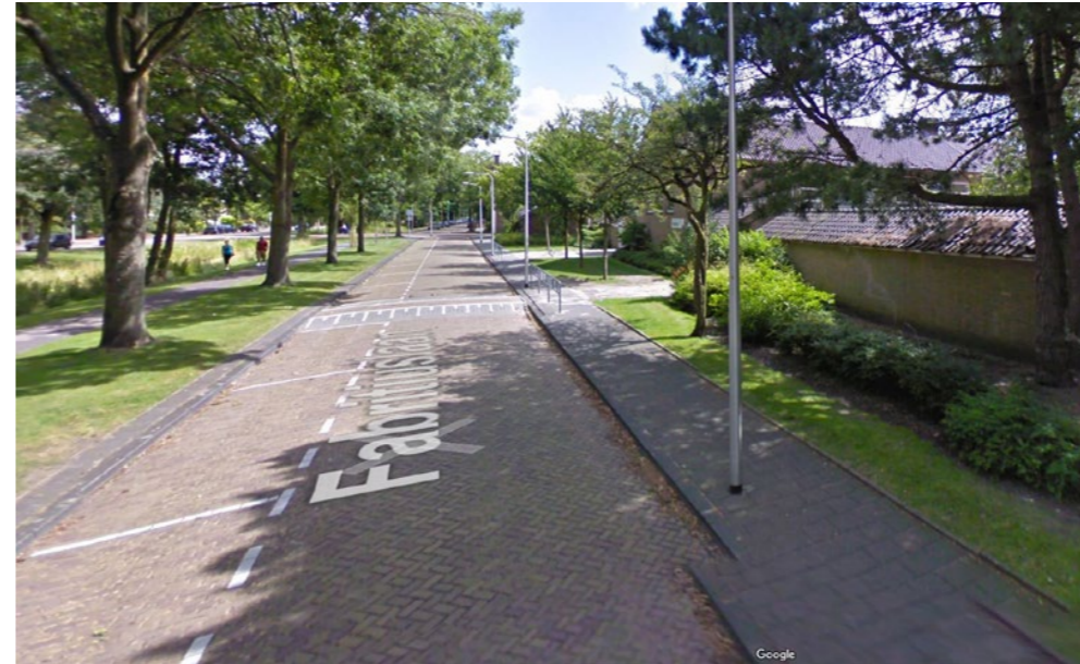
Reeds aanwezige parkeerhavens langs de Fabritiuslaan
