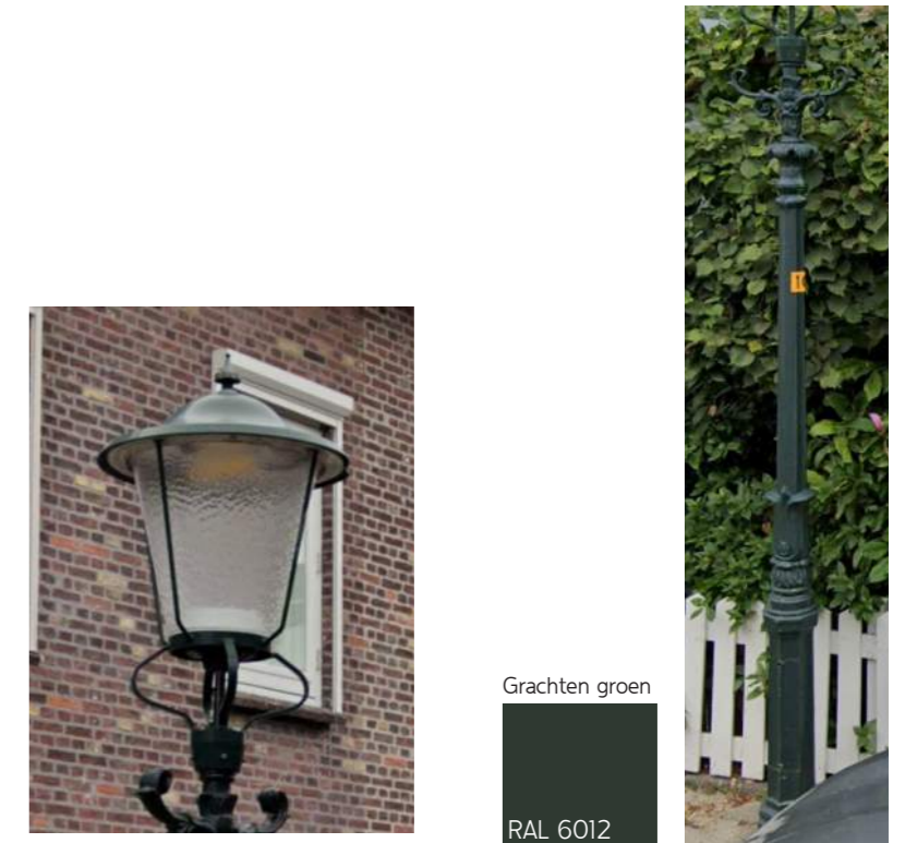
Huidige klassieke armaturen en masten behouden. Restaureren in RAL6012. Bij nieuwe aanschaf model identiek aan lichtmast t.h.v. Tuinpad 65: helder glas, RAL 6012, LED licht 3000-4000K.
