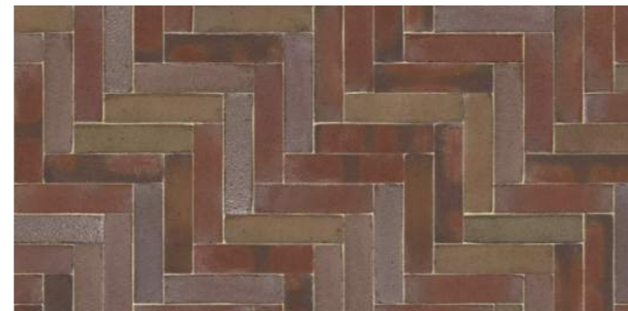
2. Loopruimte (Hollandse mix 1) Gebakken klinkers DF, Elleboogverband 42,5% DF Useton Novoton 42,5% DF Useton Varia Puur 10% DF Useton Nostalgie 5% DF Useton Geel/brons Wienerberger
