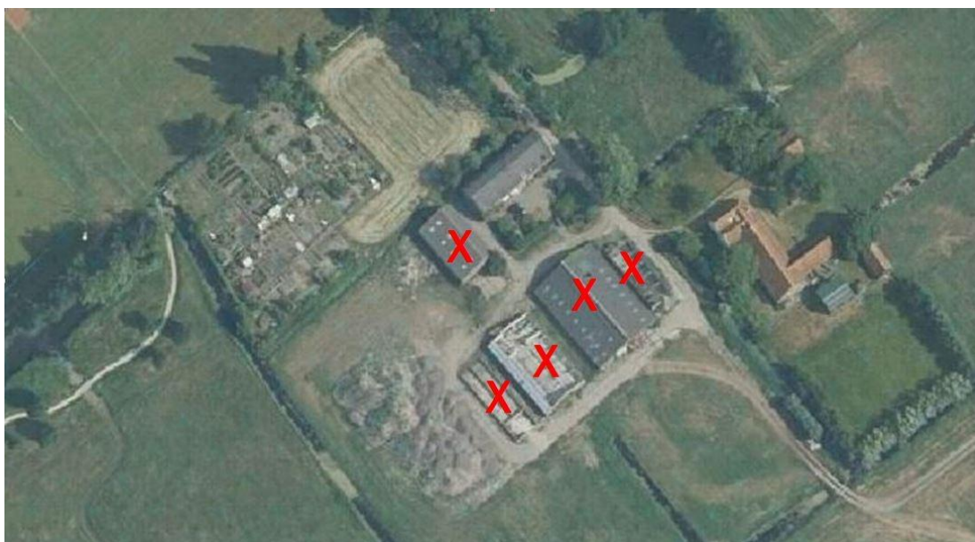
De te slopen agrarische bedrijfsbebouwing (bron: Buro SRO/google.maps)
