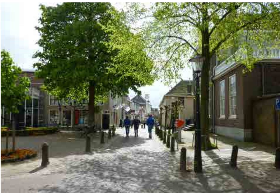
Het Plein, gezien naar Langstraat kenmerkt zich door de karakteristieke aankleding met niet alleen de dorpspomp, maar ook met hardstenen stootpalen en straatlantaarns. Rechts het Baljuwhuis dat voorzien is van een hardstenen stoep; op de hoek links het Regthuys. Foto 2015.
