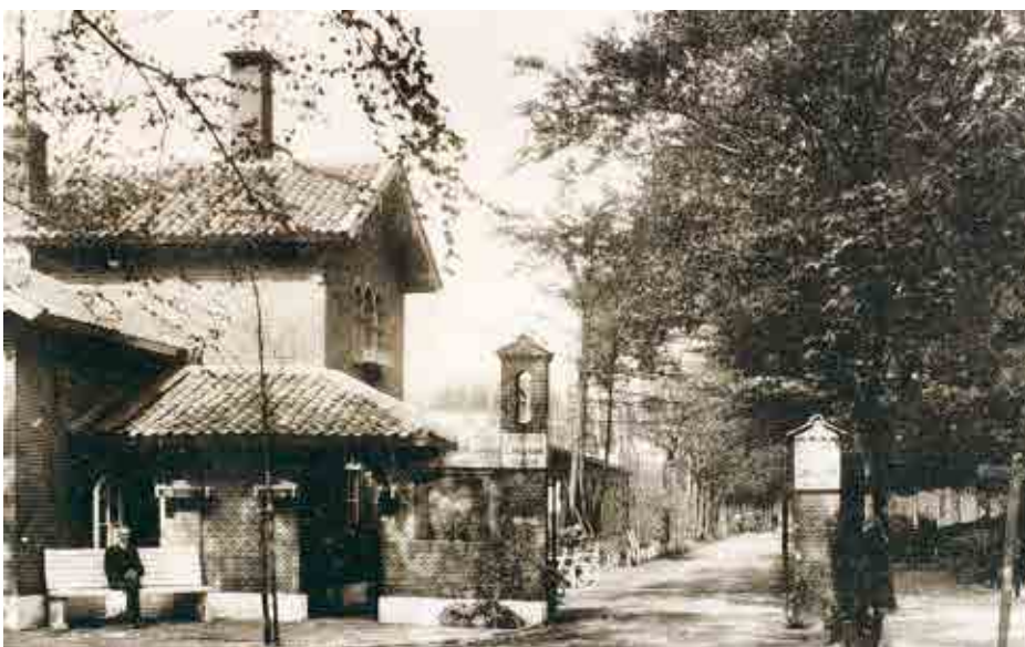
H.H.A. Wentzel bouwde bij de zuidelijk uitgang van de bezittingen van Prins Frederik deze portierswoning. Deze woning werd na de verkoop in 1898 van Groot Haesebroek, eerst als theetuin gebruikt en later weer als woonhuis. Foto ca. 1915. GAW567.
