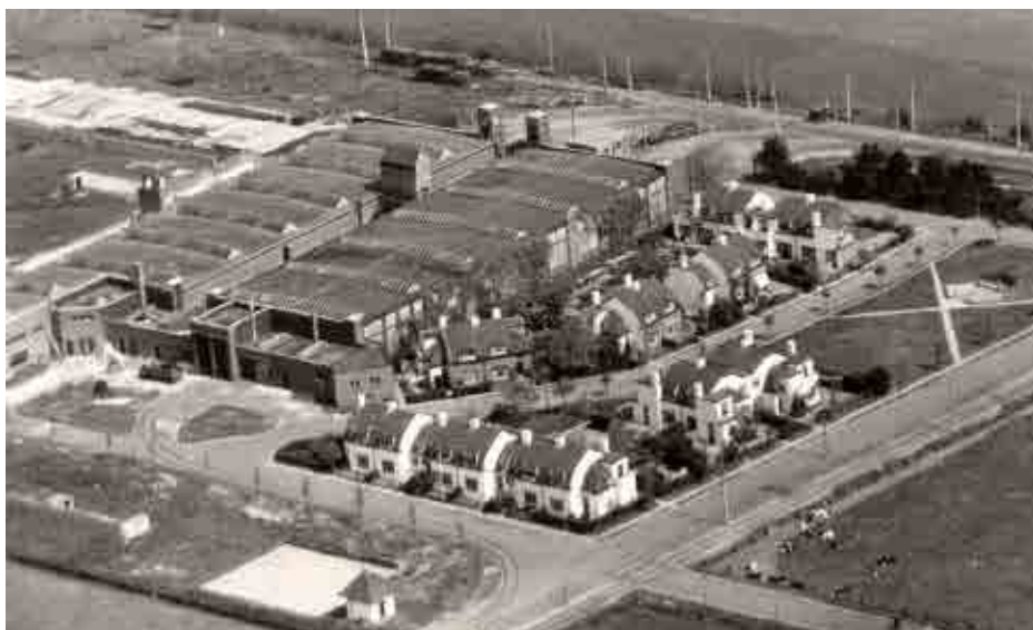
Het complex HTM-woningen werd in 1923 gelijktijdig met de remise gebouwd. De remise is in 1974 gesloopt. Foto 1955. GAW3052A.
