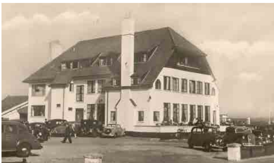
Hotel Duinoord aan het Wassenaarse Slag. Foto 1945. GAWo1898.
