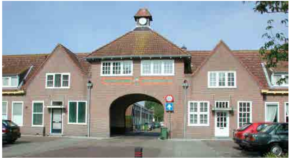
Poortgebouw aan de Bloemluststraat, Oostdorp. Foto 2008.
