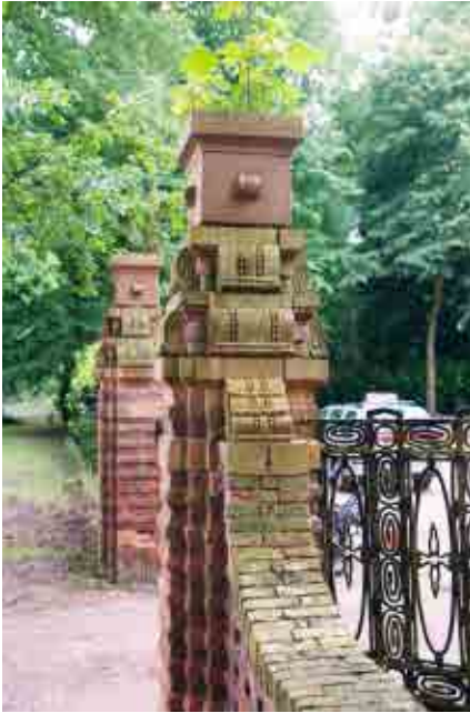
Toegangshek van De Boeckhorst op de Schouwweg 68-69 uit 1917 met bouwaardewerk van Willem Brouwer. Foto 2008.
