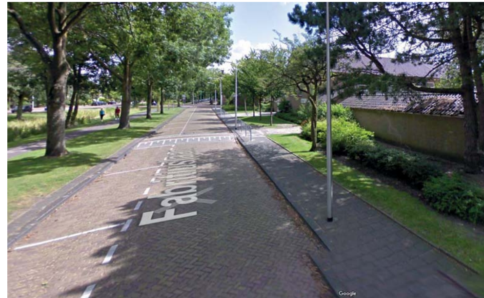
Reeds aanwezige parkeerhavens langs de Fabritiuslaan
