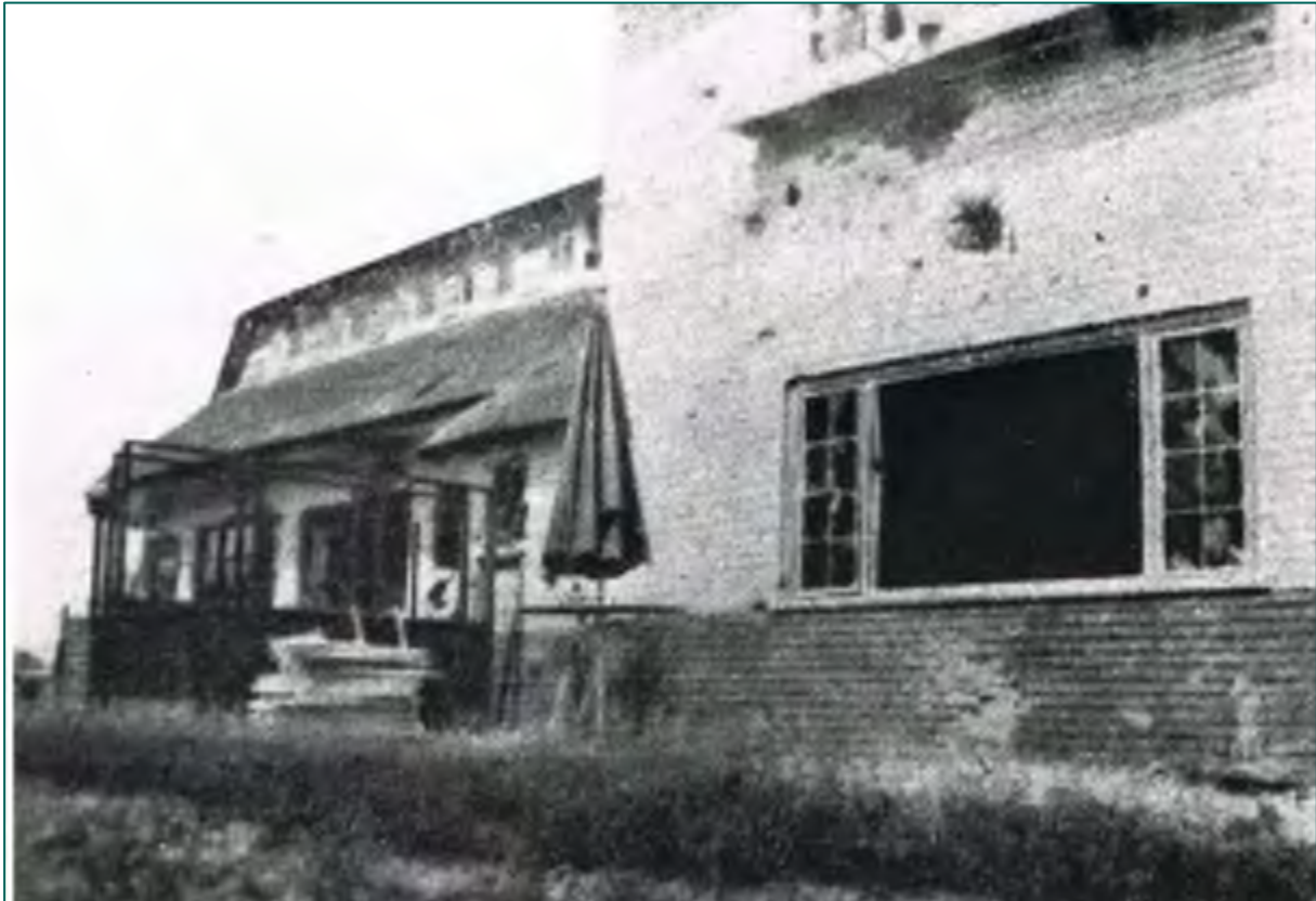
Figuur: Beschadigingen aan de Albertushof (Bron: GW, Stichting '40-'45).
