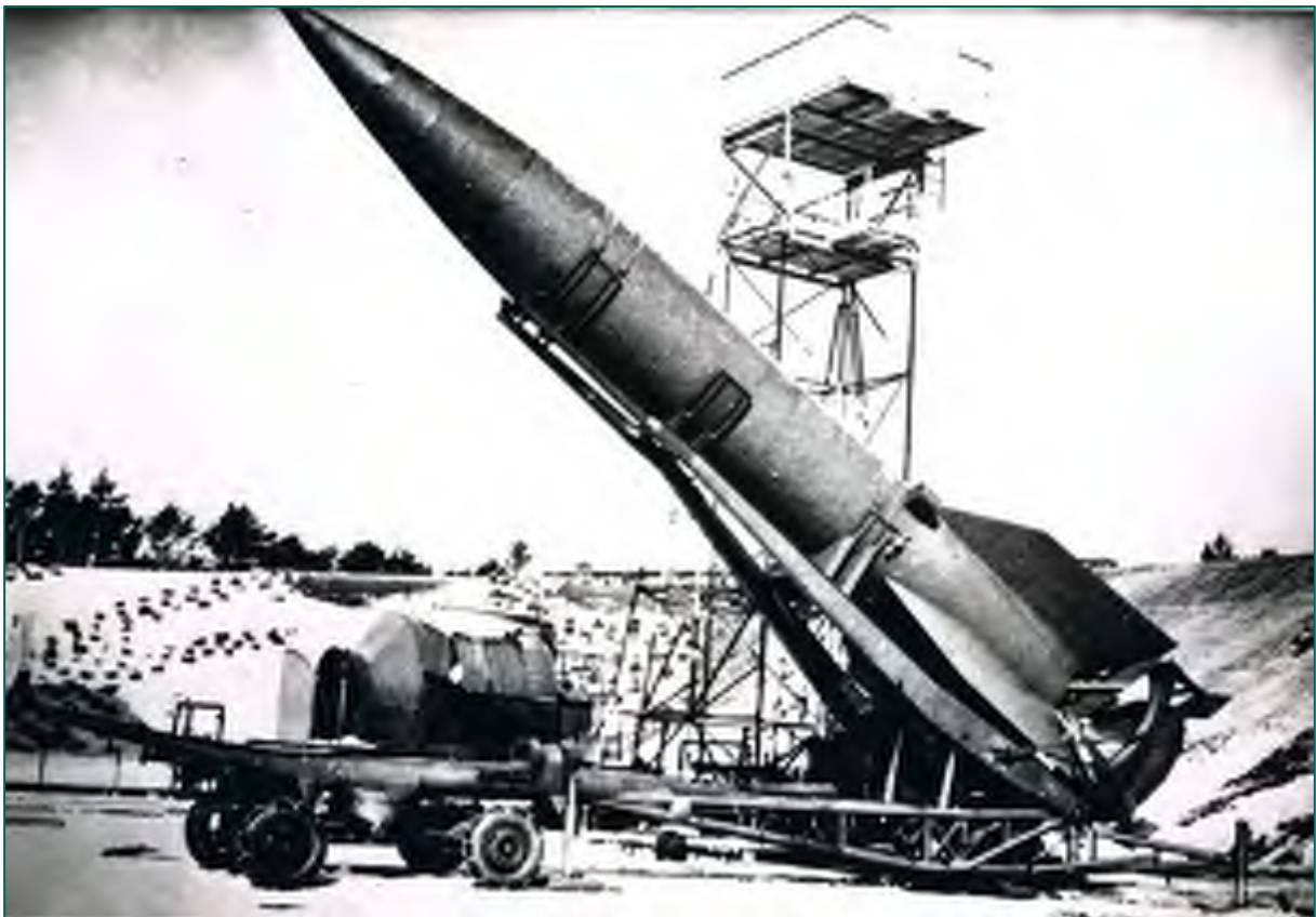
Figuur 157: V-2 op zogenaamde 'Meilerwagen'. Door het verticaal draaien van de installatie kwamen de stempels op de grond te staan, waardoor de V-2 klaar was voor lancering. De aanhangwagen links vervoerde vloeibare zuurstof, wat als brandstof diende (Bron: GW, Stichting '40-'45).
