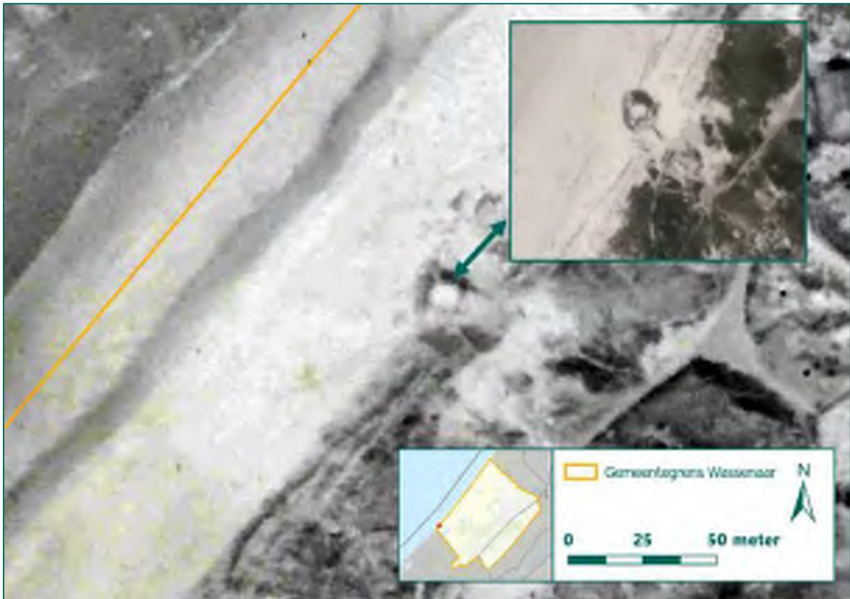
Figuur 149: Uitsnede luchtfoto 19 september 1944 waarop een kanonkazemat zichtbaar is (Bron: Wageningen UR).
