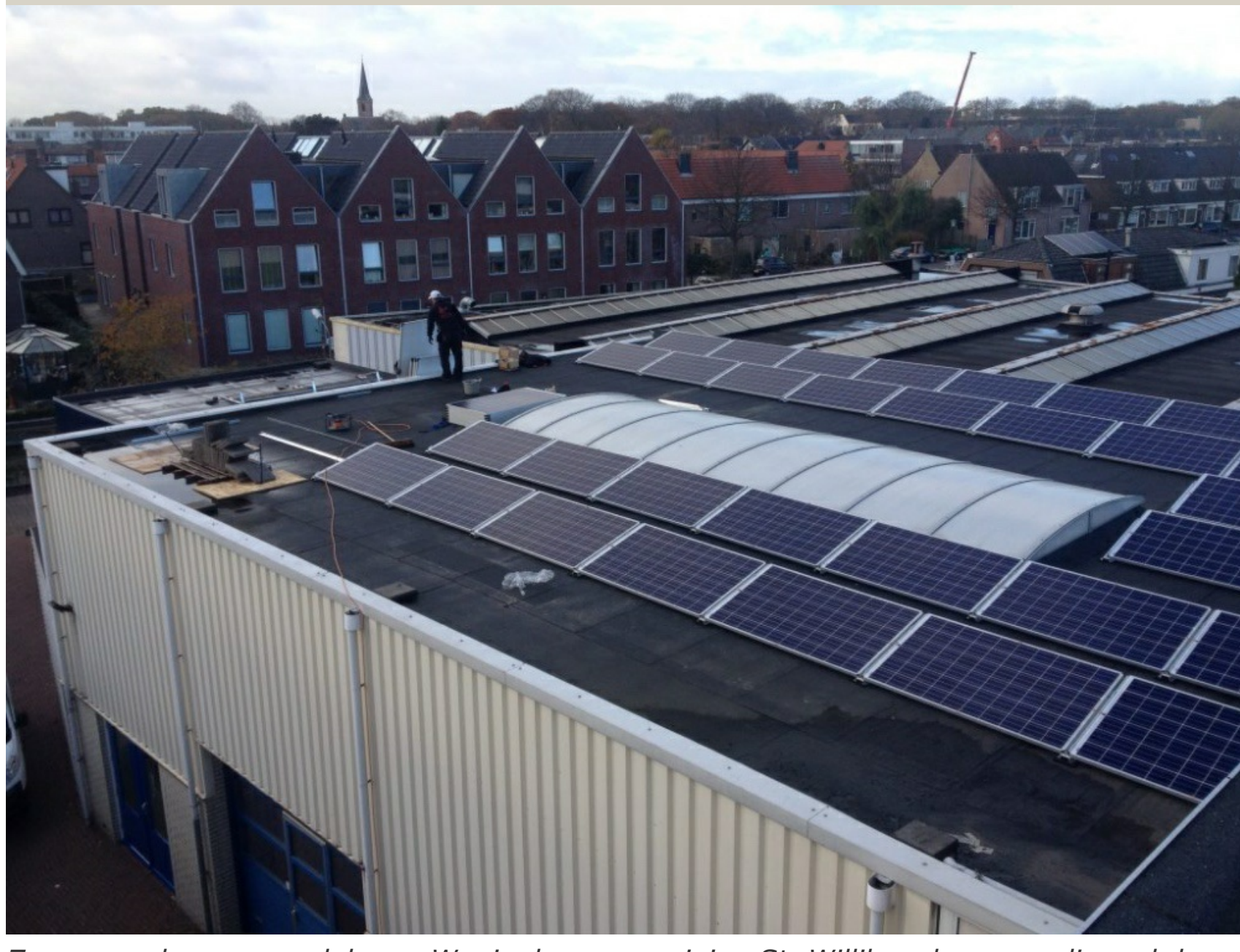
Zonnepanelen op een dak van Woningbouwvereniging St. Willibrordus, gerealiseerd door Elektro Technisch Installatie Bureau L'Ami in samenwerking met Sun is free, twee Wassenaarse ondernemingen. Foto: Pim Schra.
