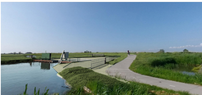
Afbeelding 3 aanduiding toekomstig gemaal Laag Blokland, bron kaart Cyclomedia Streetsmart
