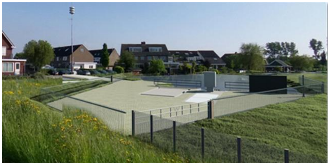
Abbeelding 6: aanduiding toekomstig poldergemaal Laag Blokland, bron kaart Cyclomedia Streetsmart
