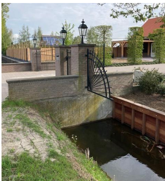
Verdediging, type: Kademuur/keermuur
