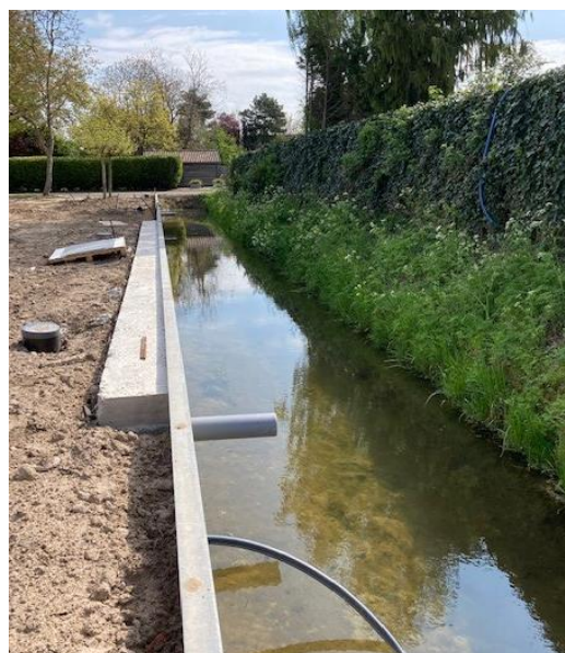
Verdediging, type: Kademuur/keermuur
