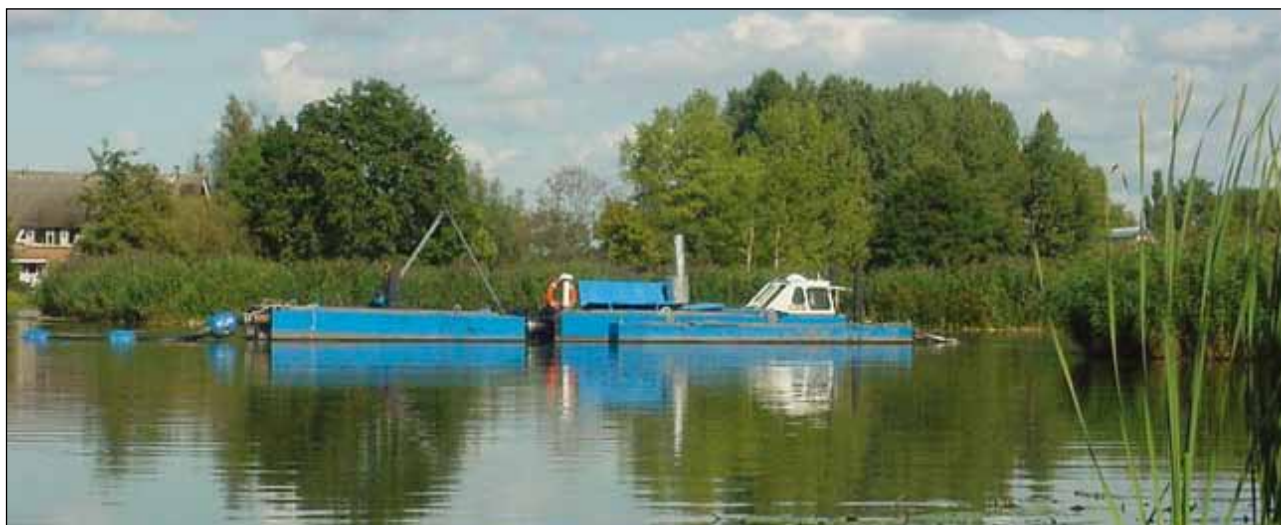
Binnen het Bbk wordt het mogelijk ook grotere hoeveelheden vrijkomende baggerspecie binnen het verspreidingsbeleid toe te passen met baggerdepots.
