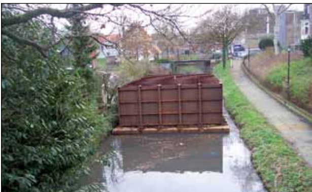
Het gebruik van een 'bombox' tijdens het baggeren van de stadsgrachten in Tiel (2006).
