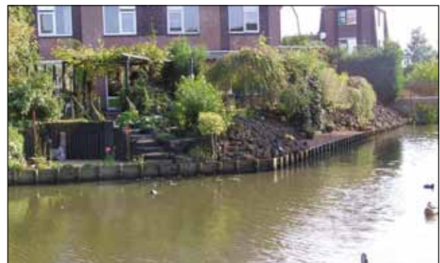
Baggeren in watergangen langs particuliere tuinen is extra lastig.
