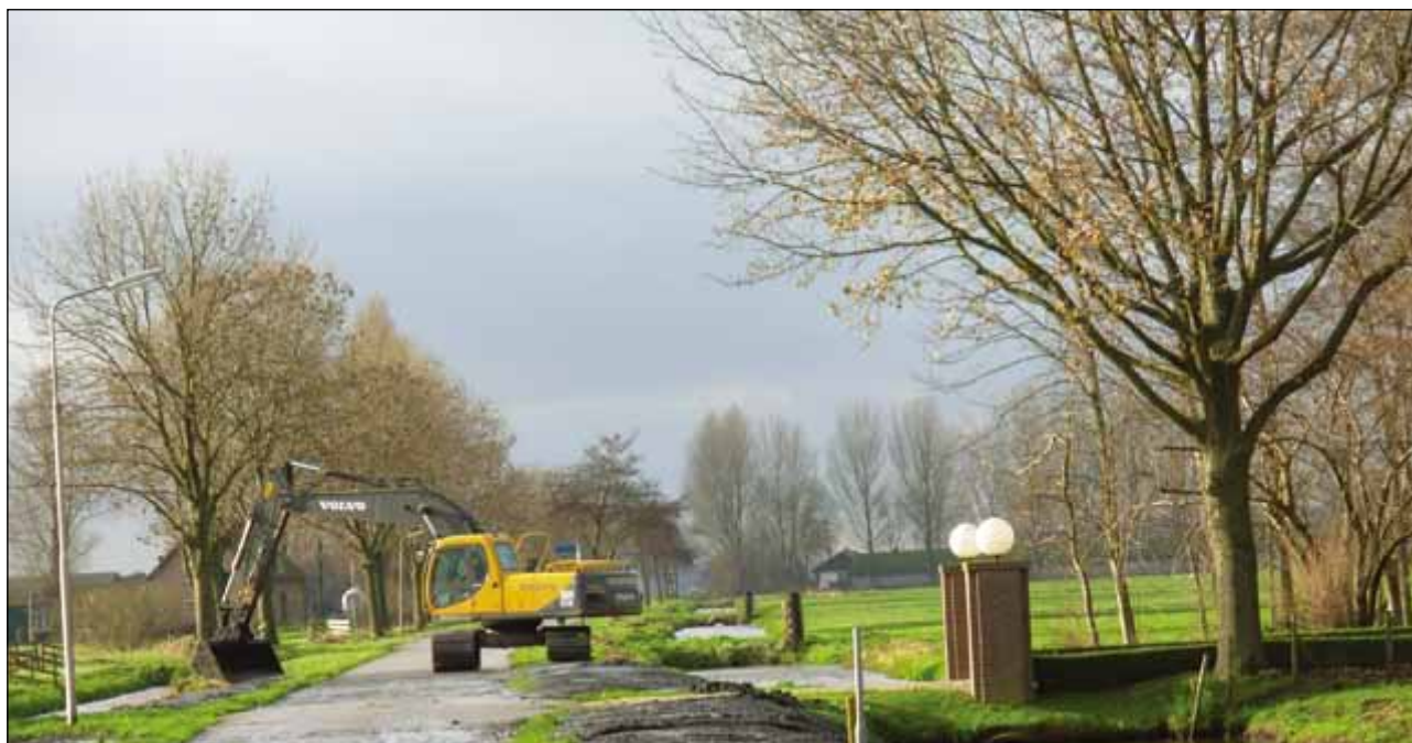
Waar mogelijk wordt verspreidbare baggerspecie op de kant verwerkt.
