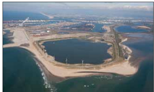
Vervuilde bagger wordt onder meer afgevoerd naar de Slufter op de Maasvlakte.
