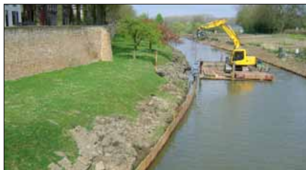
Het waterschap wil de achterstand in baggeronderhoud snel inlopen. Op de foto het plaatsen van een beschoeiing in Buren nadat de baggerwerkzaamheden waren afgerond.
