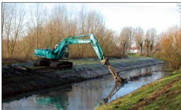
De kosten van het baggeren komen ten laste van de exploitatie van het waterschap.
