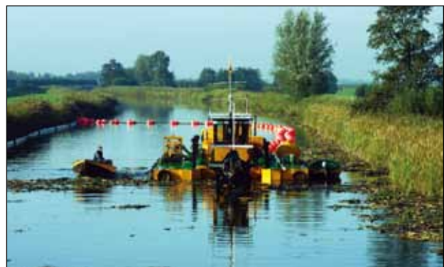
De cutterzuiger is vooral geschikt voor het baggeren van brede watergangen, zoals de lage boezems in de Alblasserwaard en de stuwvakken van de Linge.
