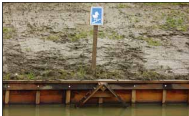
Door een vluchtrap kunnen waterdieren een veilig heenkomen zoeken.
