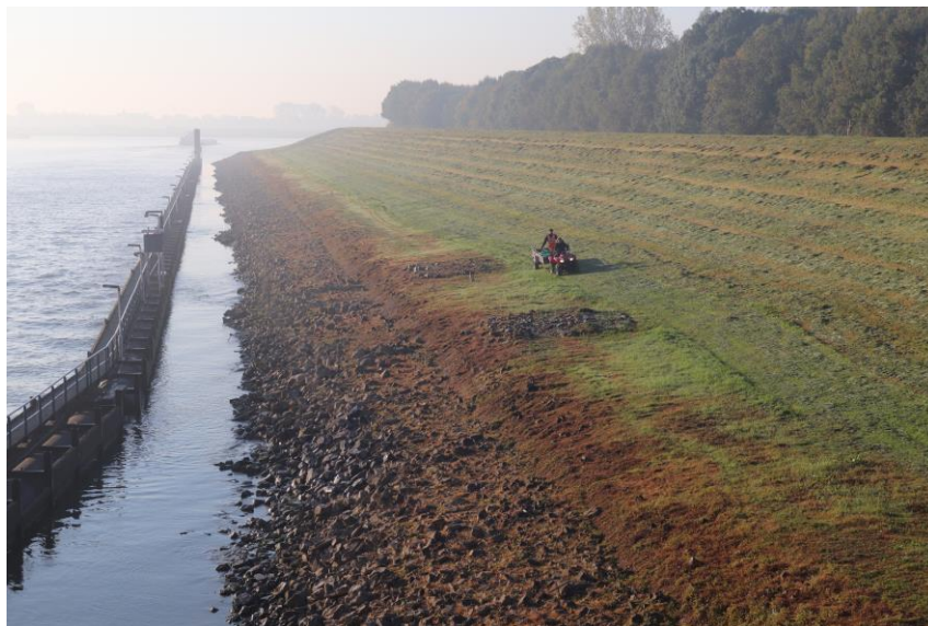
Figuur 7.2 Foto van de buitenzijde van de Voorhavendijk
