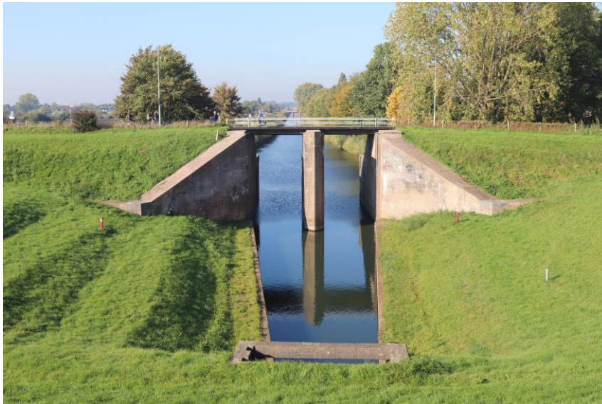
Figuur 7.7 Zicht op de inlaatsluis onder de brug, en daarachter het inundatiekanaal
