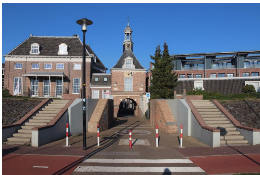
Figuur 7.4. Coupure in de dijk bij uiteinde van de Havendijk in deeltraject Stadswallen - Havendijk
