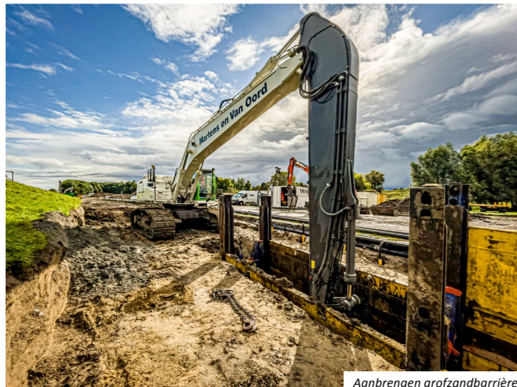
Aanbrengen grofzandbarrière
