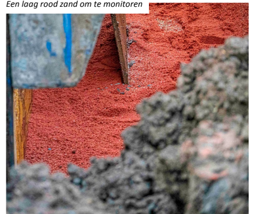
Een laag rood zand om te monitoren
