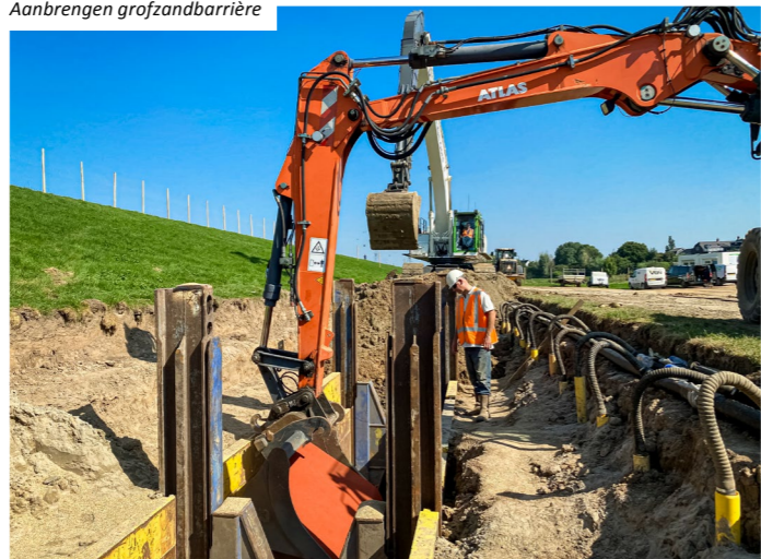
Aanbrengen grofzandbarrière
