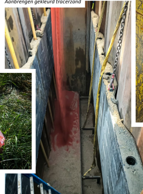
Aanbrengen gekleurd tracerzand
