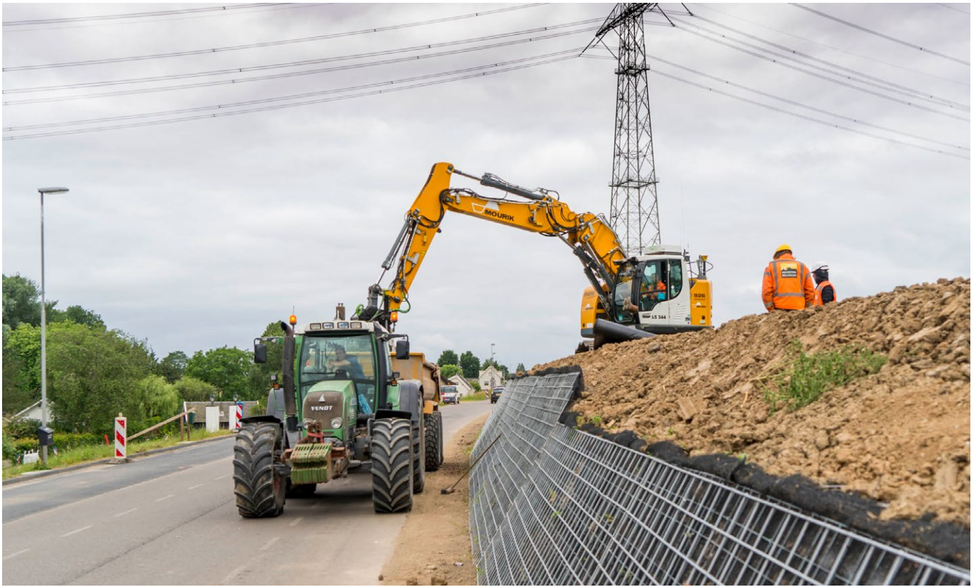
Afwerken steil talud tussen fietspad op de tuimelkade en de rijweg op de Lekdijk in Nieuw-Lekkerland
