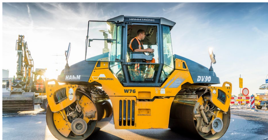
Asfalteringswerkzaamheden microtonde Nieuw-Lekkerland
