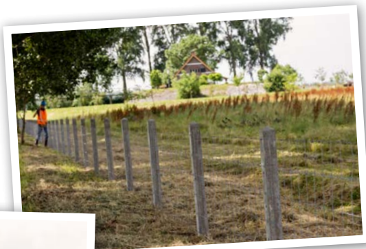
Overal in het gebied is afrastering geplaatst, met hekken voor de doorgang.
