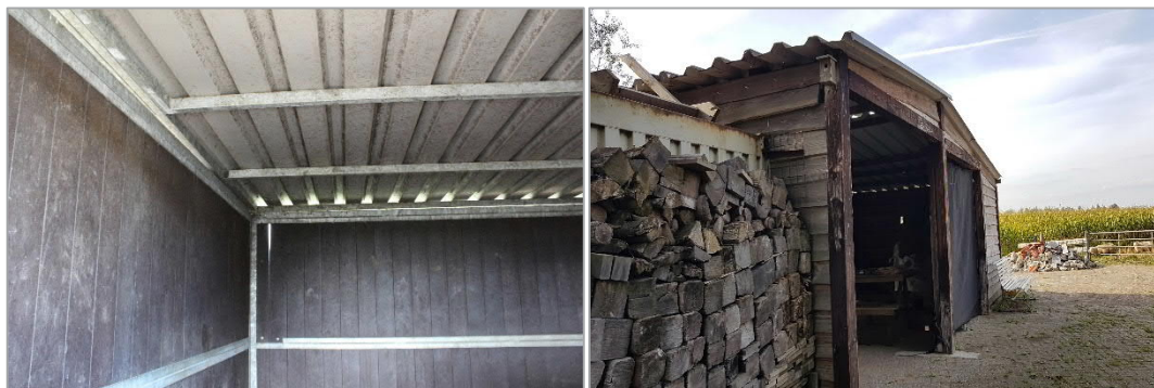
Figuur 4.15 Links de binnenkant van de paardenstallen, rechts de schuur op het 'volkstuinten' terrein tussen de A15 en Rivierdijk.
