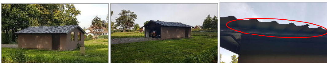
Figuur 4.7 Garage aan de Neerpolderseweg 72 A
