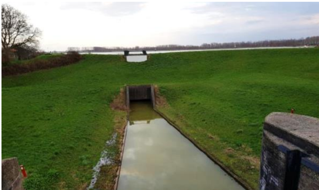
Figuur 4.36 Zicht op de dijk: huidige situatie gezien vanaf de weg op de voormalige sluis.
