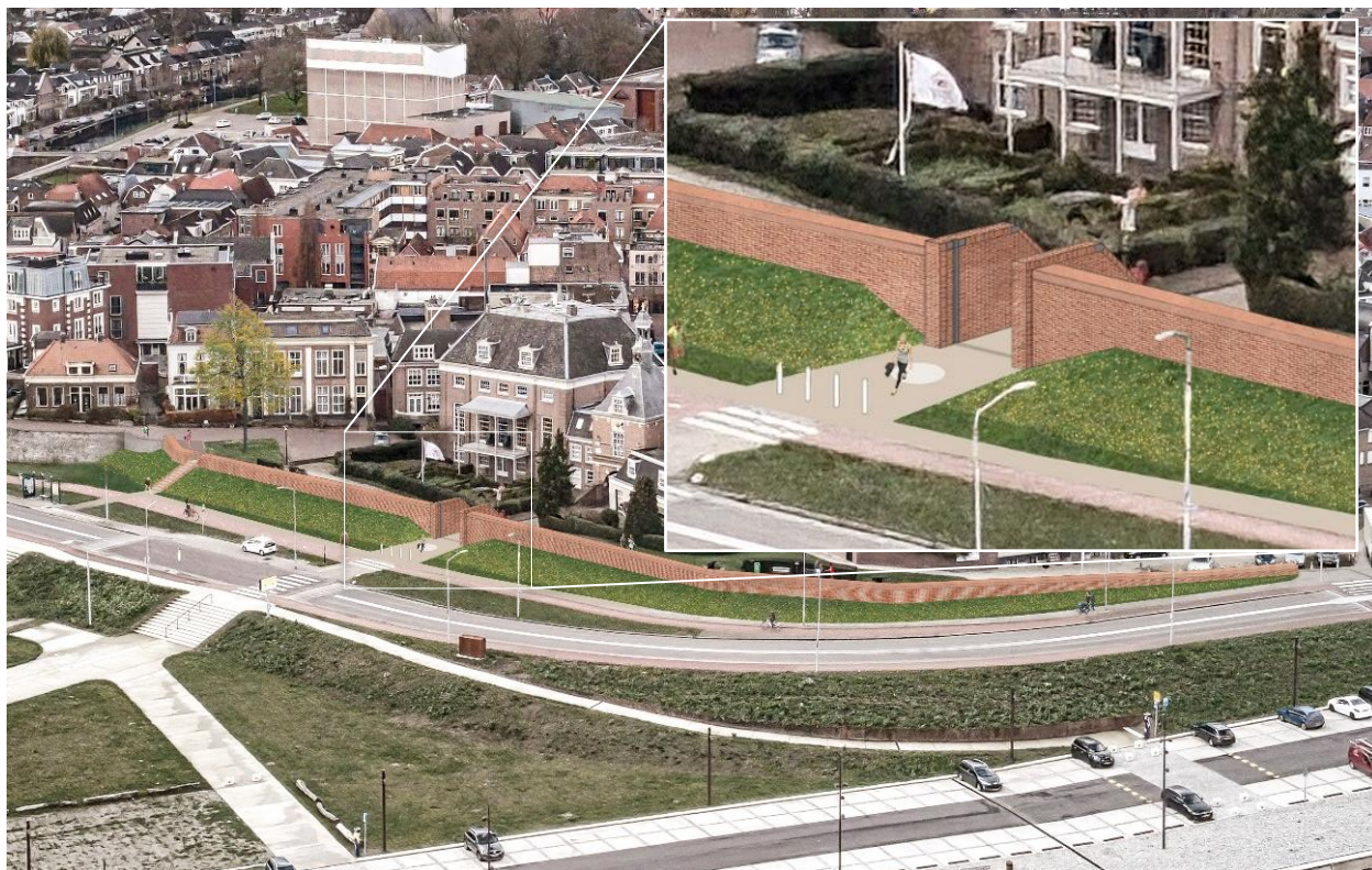
Figuur 4.17 Visualisatie van de gekozen oplossing in deeltraject 4A, met in het kader de coupure Waterpoort.
