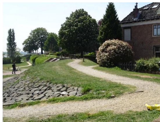
Figuur 5.3. Huidige wandelroute over de kruin van de dijk.
