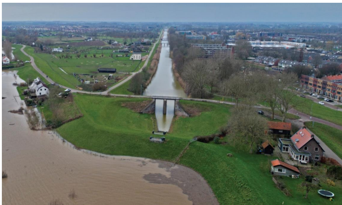
Figuur 4.35 Deeltraject 6: Inlaatduiker Inundatiekanaal met rechts de voormalige sluiswachterswoning en overstortleiding
