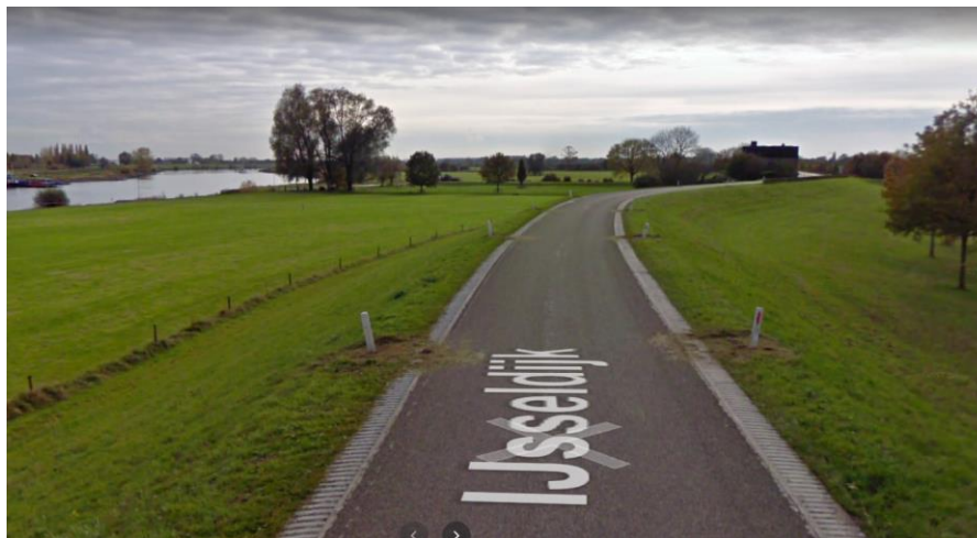
Figuur 4: Voorbeeld toepassing van bochtreflectorpalen IJseldijk te Welsum (bron: Google Maps)
