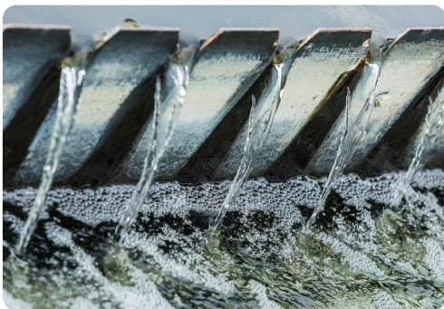
Figuur 17: Effluent goot
