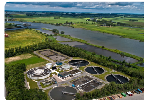
Figuur 18: Luchtfoto rwzi Kampen
