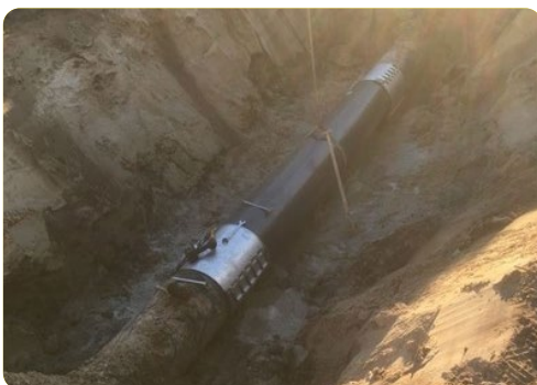
Figuur 16: Nieuwe leiding segment
